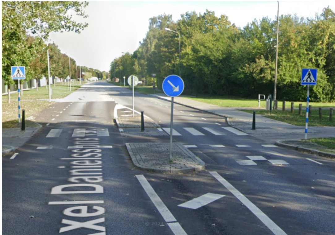
Befintlig hastighetsdämpande åtgärd vid övergångsställe över Axel Danielssons väg vid Fosieborgsstigen.
