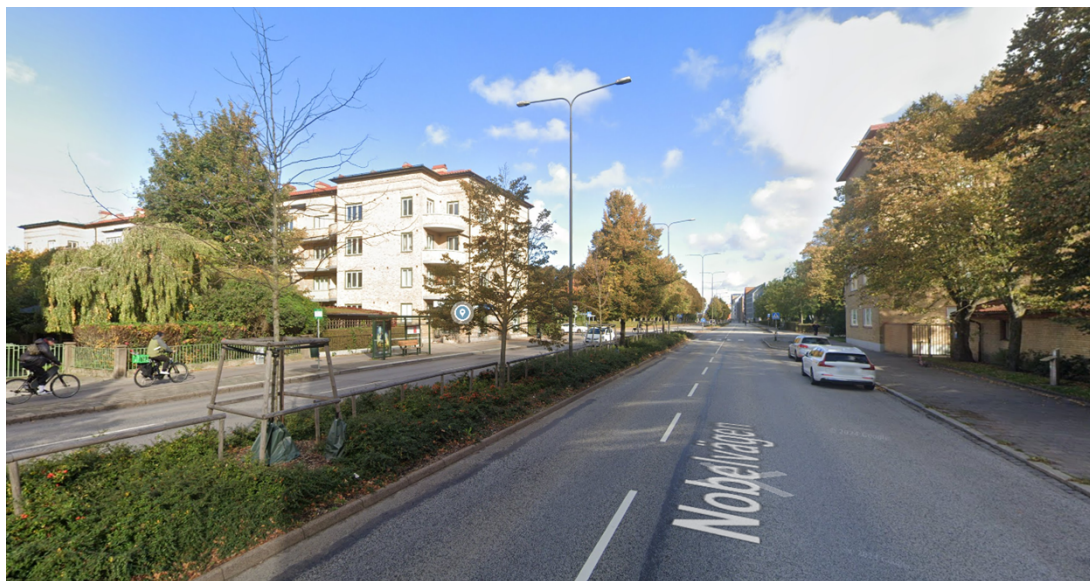
Figur 2 Bild som visar trottoarer längs båda sidor av Nobelvägen och cykelbana längs den västra sidan. Planteringar finns i mitten av vägen och parkering förekommer längs med den aktuella sträckan.
