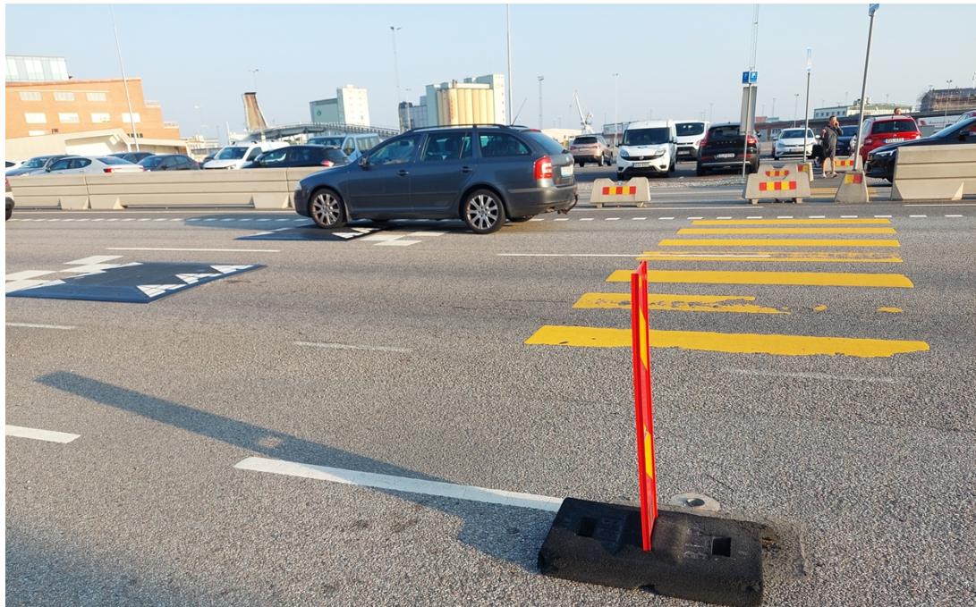
Figur 5: Vy av befintlig åtgärd 2024-09-05.
