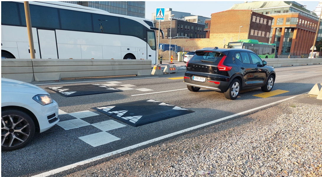
Figur 3: Vy av befintlig åtgärd 2024-09-05.
