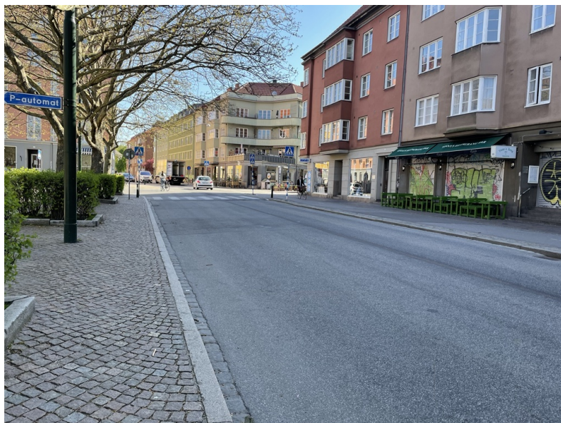
Figur 1. Södra delen av S:t Knuts väg.
