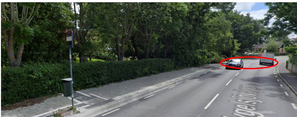
Figur 5. Befintligt farthinder, södergående riktning. Här syns även busshållplats för resande norrut.
