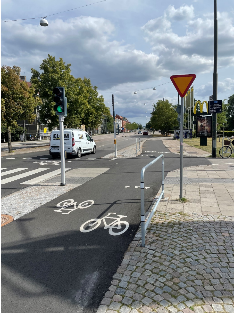
Bild 3. Ystadvägen-Heleneholmstigen. Ny signalreglering på befintligt övergångsställe med cykelöverfart.
