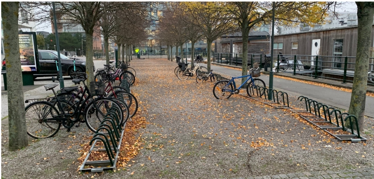
Före åtgärd. Propellergatan med tillfälliga cykelställ utan möjlighet att låsa fast cykeln.
