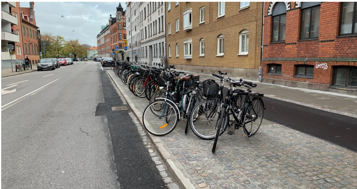
Efter åtgärd. Förlängd klack med smågatsten, framhjulställ har ersatts med cykelbågar och antalet cykelplatser har utökats.
