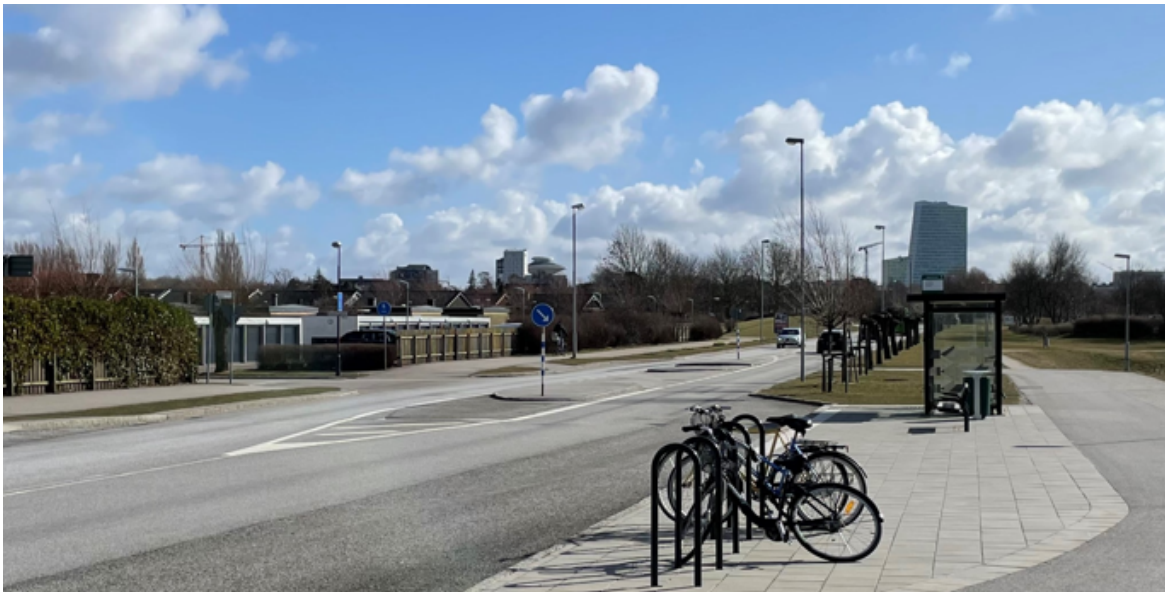
Figur 8. Korsningen Annetorpsvägen/Diakongatan. Hållplats Djupadalstigen i förgrunden
