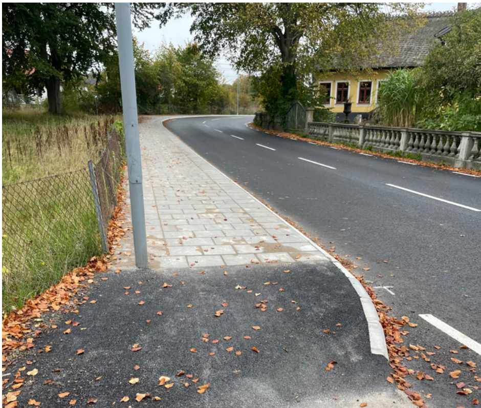
Kristinebergsvägen efter åtgärd.
