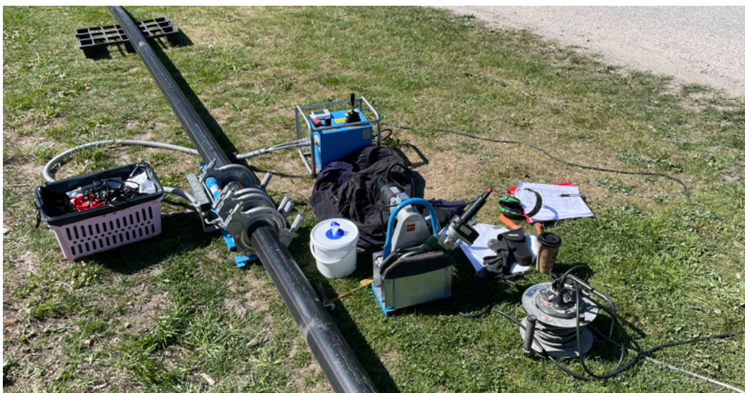
230530 Ledningen svetsas ihop innan provtryckning.
