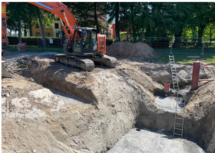
230602 Schaktningsarbeten för pumpstation.
