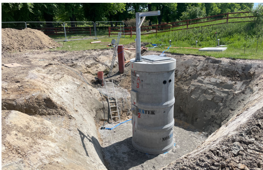
230605 Pumpstationen på plats
