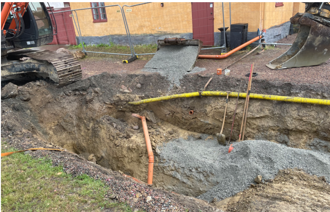
Schaktning för inkoppling av Östra längan till både dagvatten och spillvatten samt förberedelser för sättning av ny fettavskiljare. Nya dagvattenledningar läggs där schaktarbeten utförs.
