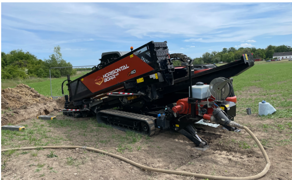
230529 Borrning under vallen och in i Almviksparken, en sträcka av drygt 200 meter. Borrning var föreskriven under vallen till Almvik för att slippa schaktning i vad som sades vara massor av tvivelaktigt ursprung.
