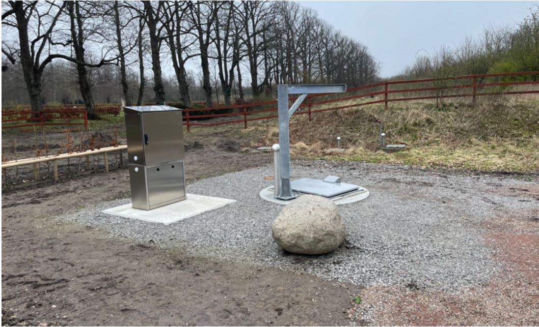
240405 Spår efter pumpstationen, elskåp och lyftanordning. Plantering av häck för att så småningom dölja pumpstationen för besökare.
