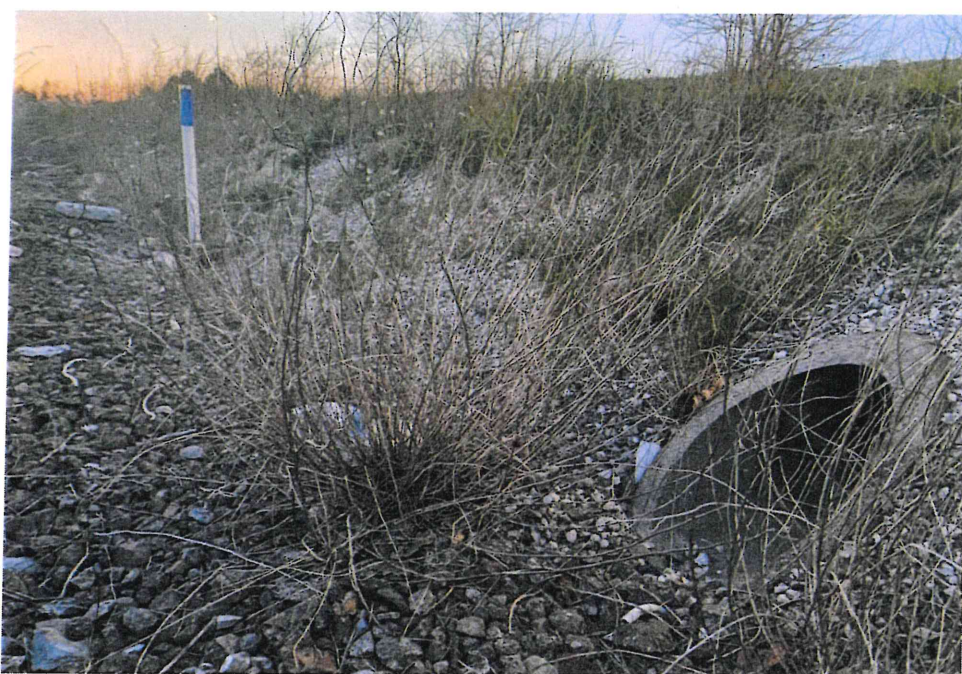
Mynning på en av de anlagda tunnlarna under Verkögatan.
