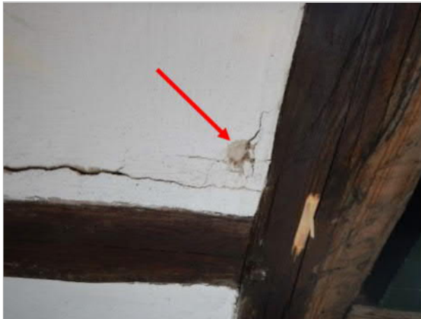
Tidigare prov uttaget på invändig puts
