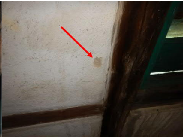
Tidigare prov uttaget på invändig puts
