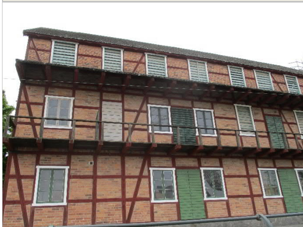
Nyare prov taget på fönsterkitt
