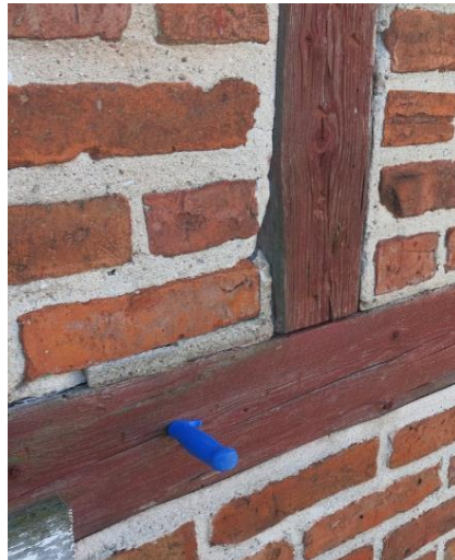
Figur 19 och 20. Rötskador och lösa knutpunkter i korsvirket. Foto 2017. Restaurera AB.
