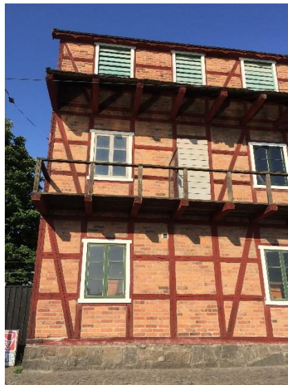
Figur 10. Del av östra fasaden. På tredje våningen finns ställbara träjalusier.
