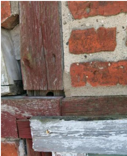
Figur 19 och 20. Rötskador och lösa knutpunkter i korsvirket. Foto 2017. Restaurera AB.
