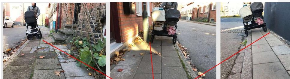
Smala gator med fasta utstickande konstruktion i trottoaren från presentation Byalaget Sofia.
