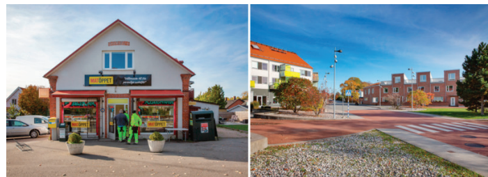
Till vänster: livsmedelsbutik i Klagshamn. Till höger: torgbildning utan verksamheter i Klagshamn.
