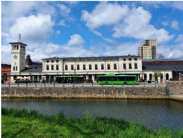
Figur 116. Malmö Centralstation, den äldre delen från 1856.
