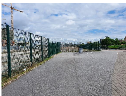
Figur 194. Asfaltyta på terminalens nordöstra hörn
