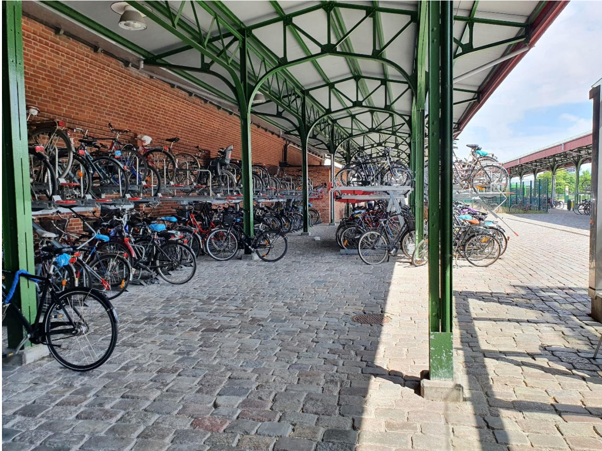
Figur 70. Tråvåningsställ vid östra Centralplan.
