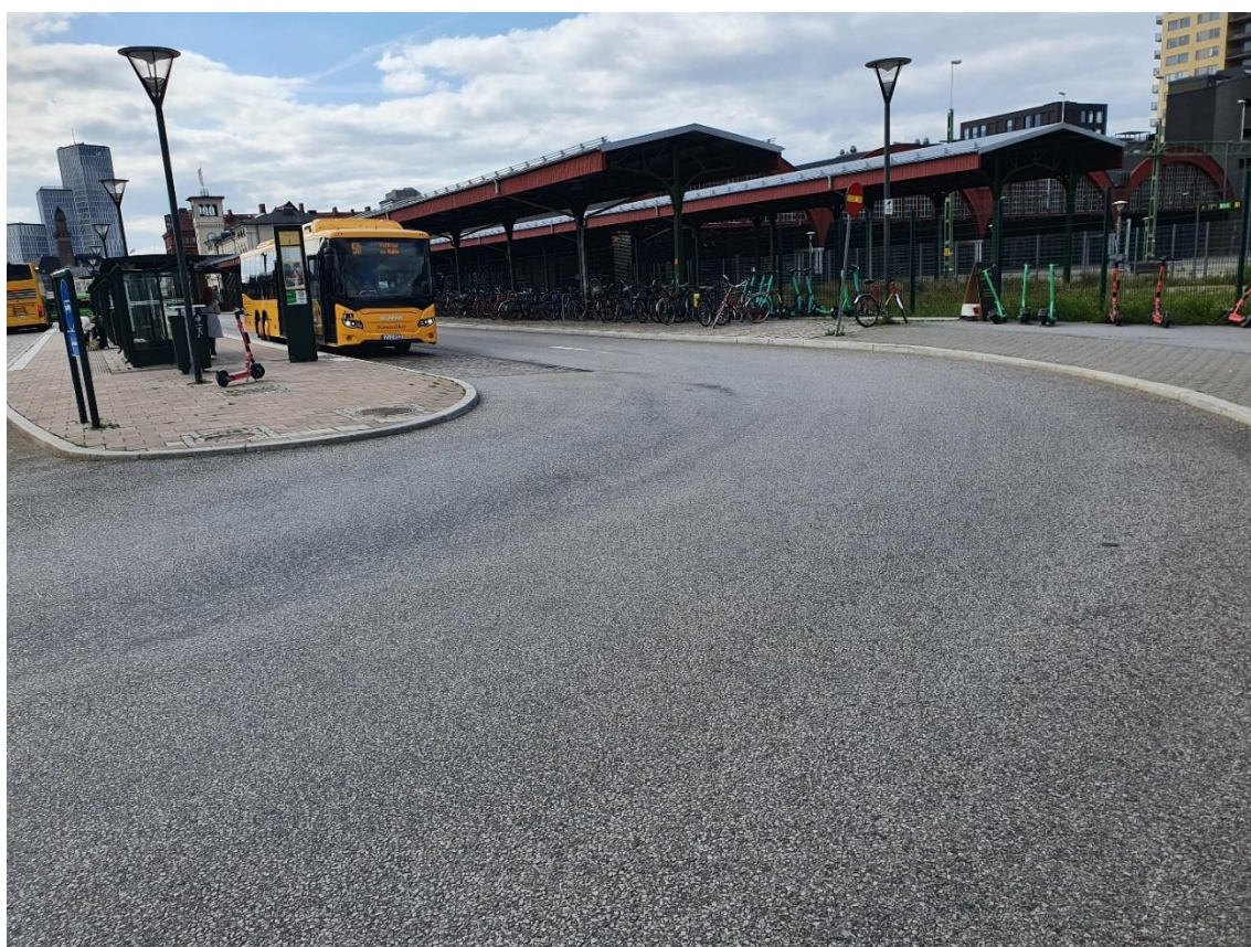
Figur 137. Spårbildning i södergående riktning Centralplan - Centralbron.
