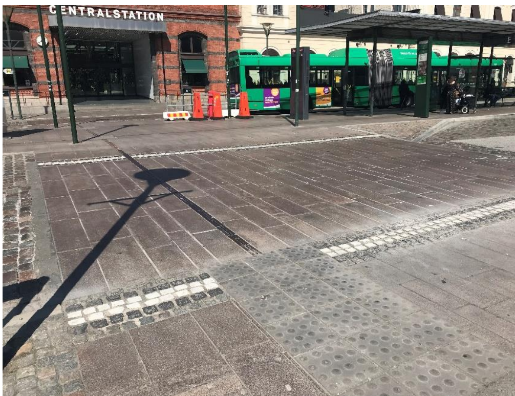
Figur 40. Taktila plattor vid passagen över busskörfälten i anslutning till Centralens huvudentré.
