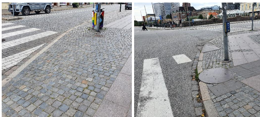
Figur 39. Till vänster: Passagen över Hamngatan är ej tillgänglighetsanpassad för personer med nedsatt syn. Till höger: Tillgänglighetsanpassningen är inte godkänd med hänsyn till förskjutning mellan sinusplattor och kupolplattor.
