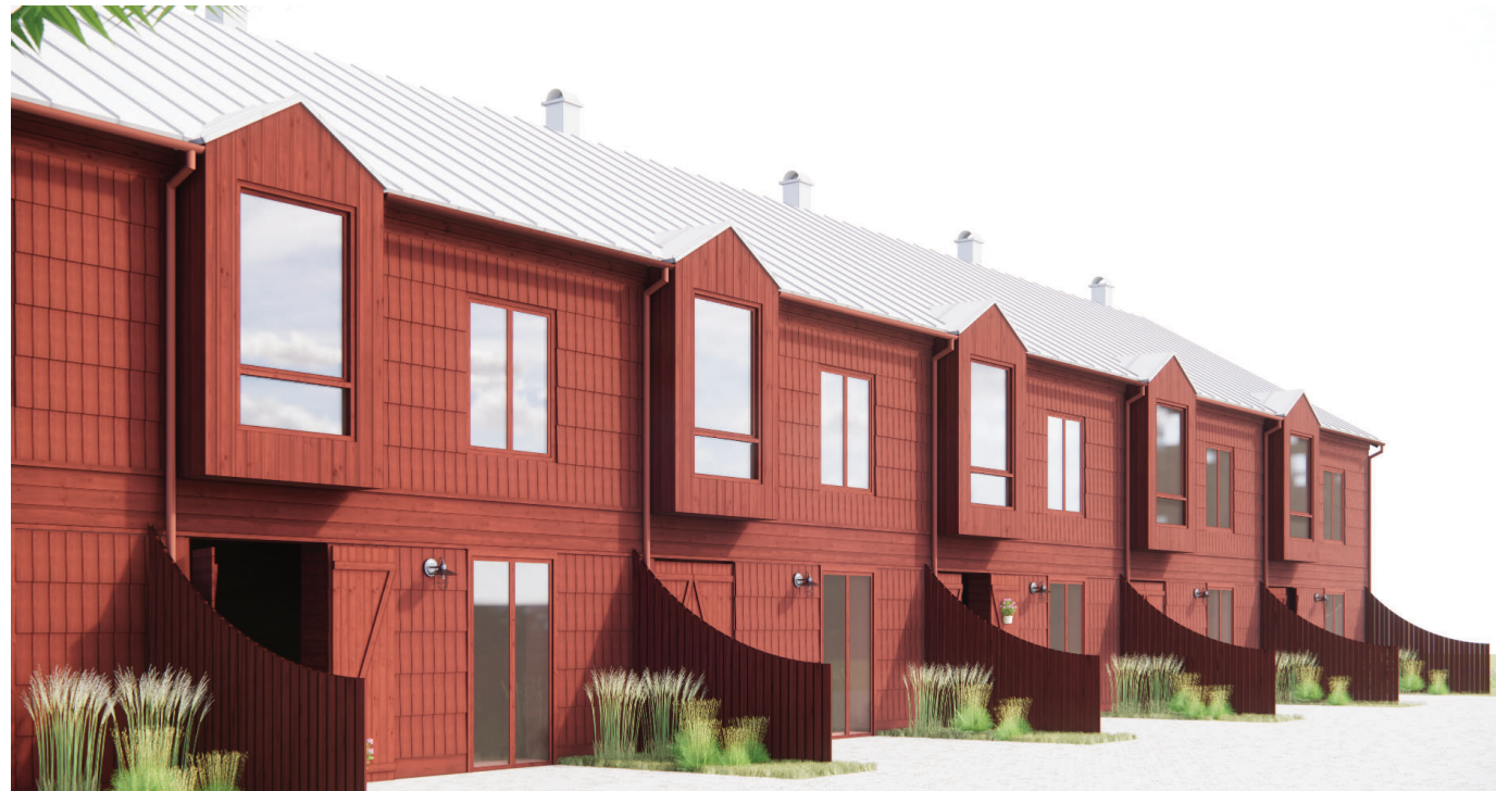
Radhuslängorna, i norr och väster, har burspråk och portar inspirerade av lantbruksbyggnader.
