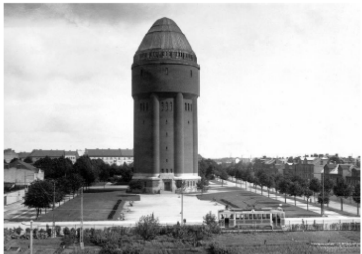
Figur 1 Foto som visar platsens ursprungliga gestaltning. Källa Sydsvenskan (bild från antikvarisk förundersökning)
