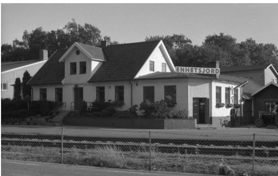
Fotografi från 1970-talet på det äldsta bostadshuset (byggnad 2) med järnvägen i förgrunden (Restaurera, 2025-06-17).
