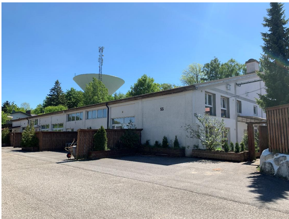
Foto på byggnad 7. Vy från norr (Malmö stad).
