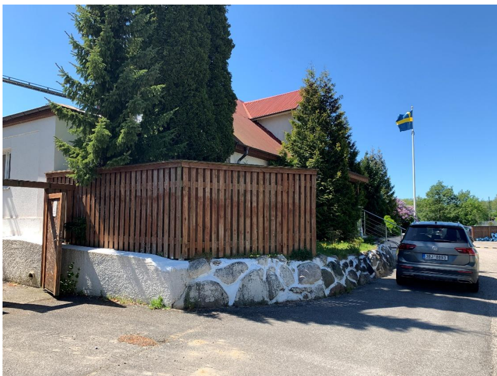
Foto på byggnad 2 med tujor och mindre gräsmatta vid entrén. Vy från öster (Malmö stad).
