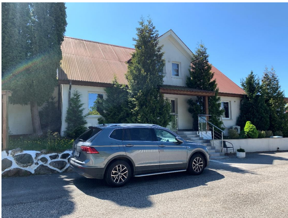
Foto på byggnad 2. Vy från norr (Malmö stad).
