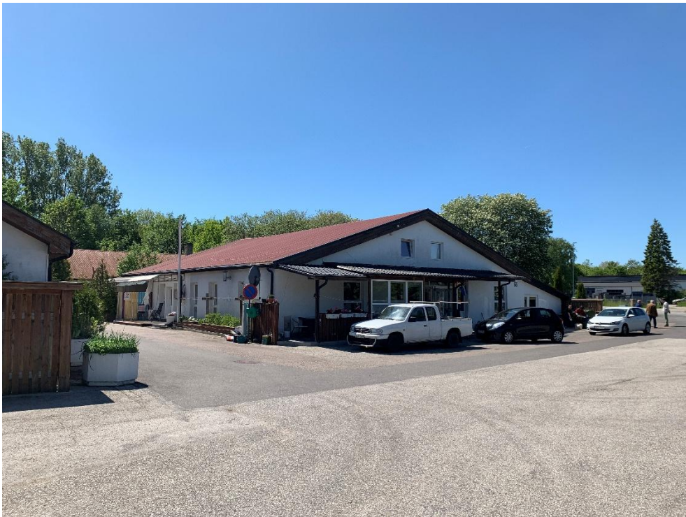
Foto på byggnad 1. Vy från norr (Malmö stad).
