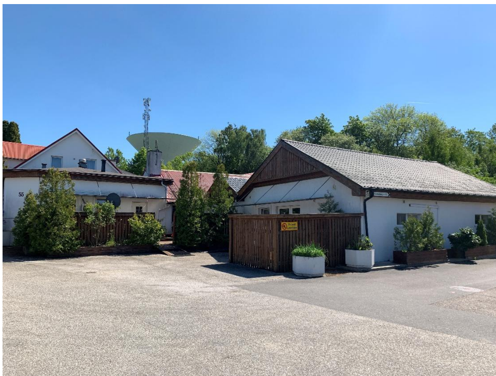
Foto på byggnad 5, till höger i bild. Vy från norr (Malmö stad).
