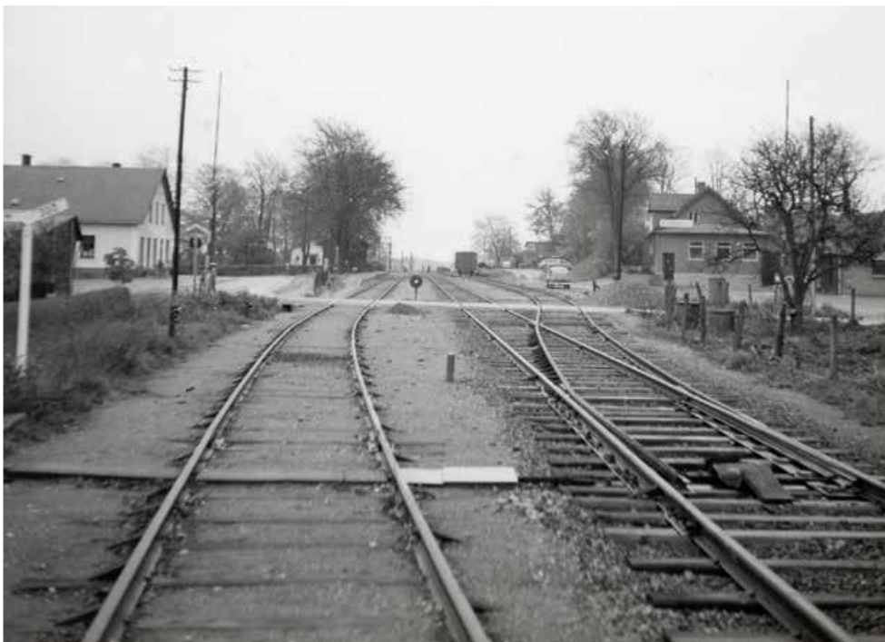
Fotografi från år 1957 med vy över spårområdet. Planområdet till höger i bild (Restaurera, 2025-06-17).
