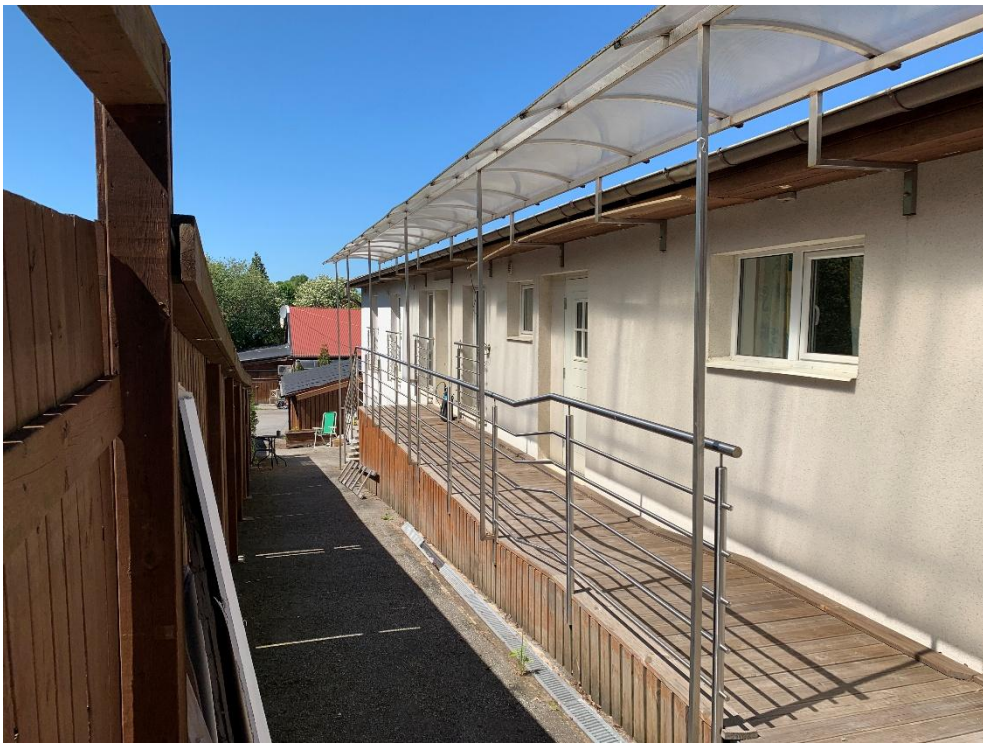
Foto på byggnad 6 där ingång sker via loftgång. Vy från öster (Malmö stad).
