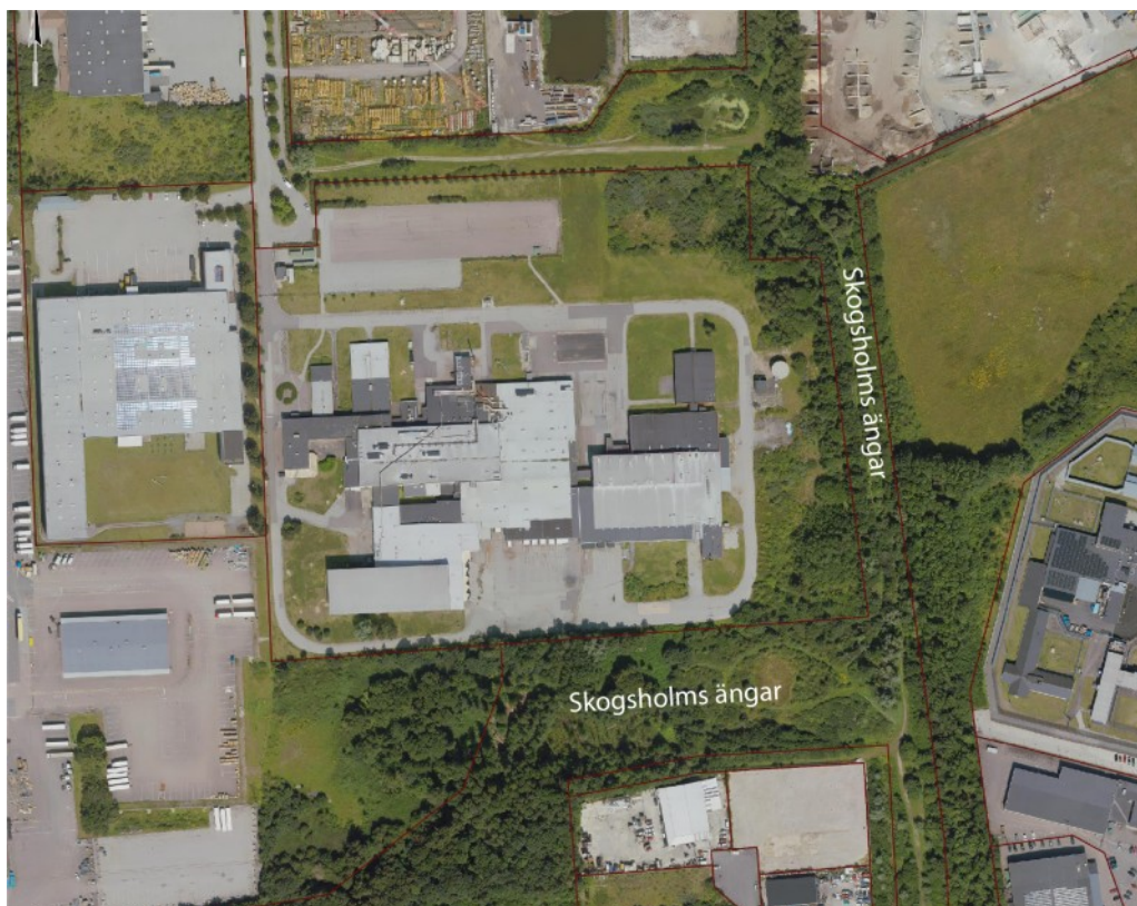
Skogsholms ängar omger fastighetens norra, östra och södra sida med grönska och ett rikt naturliv.
