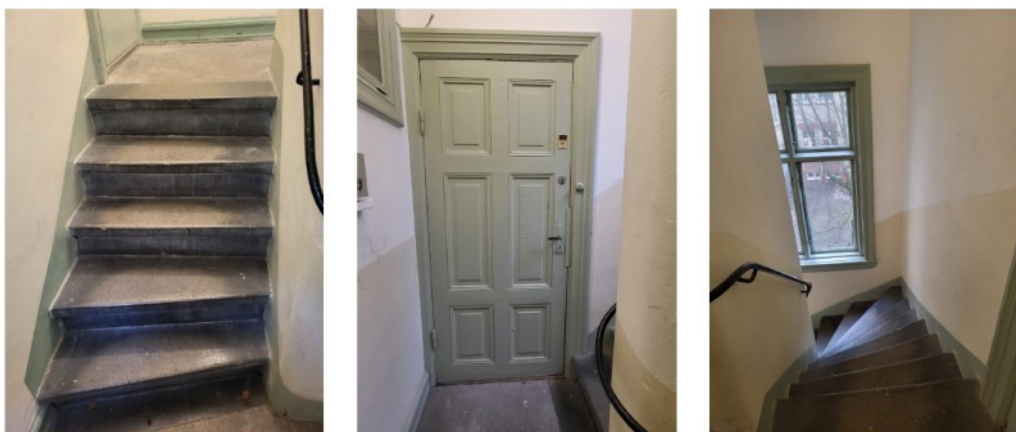
Figur 16. Indraget pigtrapphus med rekatangulär planform i gårdsflygeln. Gjuten betongtrappa. Enkla handledare i svart smide. Spegelindelade enkeldörrar. Korspostfönster med fyra lufter. Profilerade foder till fönster och dörrar och profilerade golvlister. Källa: Tyréns Sverige AB, 2025.
