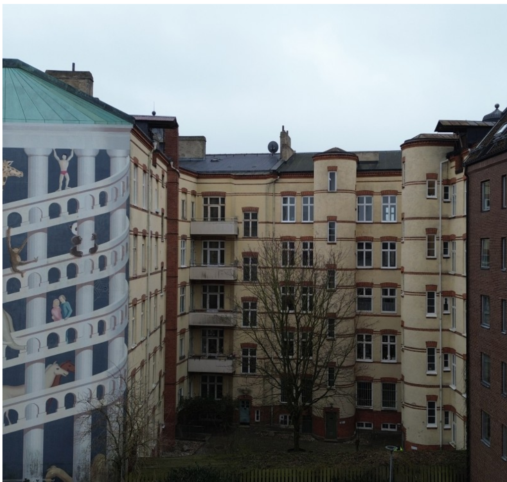
Figur 14. Flygvy över gårdsfasaderna. Källa: Tyréns Sverige AB, 2025.
