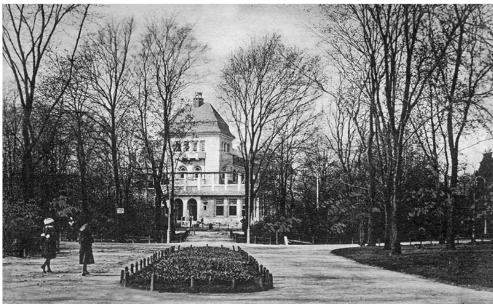
Restaurangpaviljongen efter rivningen av utanpåverket i trä och ombyggnad 1914. Fasad mot öster. Infarten från Slottsgatan hade vid denna tid en mer parklik karaktär med raka siktlinjer men slingrande gångvägar. Dagens breda infartsgata tillkom först i samband med ombyggnaden till kasino i början av 2000-talet. Källa Malmö stadsarkiv.
