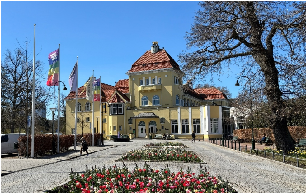
Restaurangpaviljongen idag. Fasad mot öster. Foto Malmö stad.
