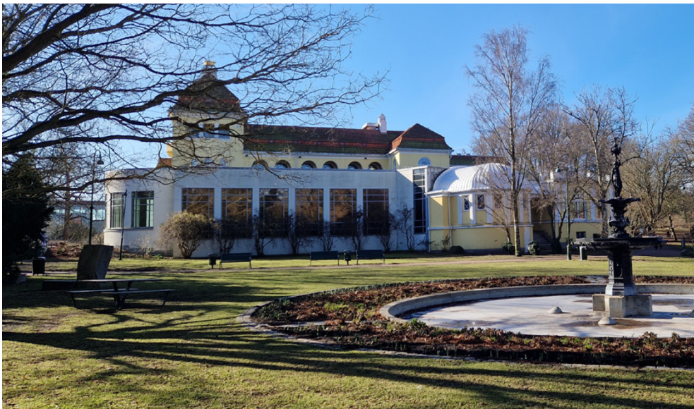
Restaurangpaviljongen med tillbyggnaden från 2001 framför. Fasad mot norr. Foto Olga Schlyter.
