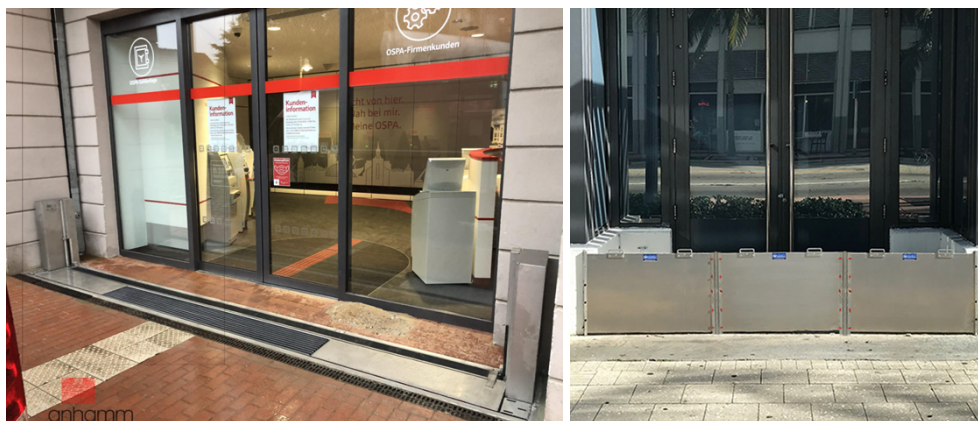
Bild till vänster: Exempel på semi-permanenta skydd som stängs vid behov. Bild: Anhamm Liquid Barrier Products GmbH. Bild till höger: Exempel på temporära skydd som sätts på plats vid behov. Bild: Aggeres.
