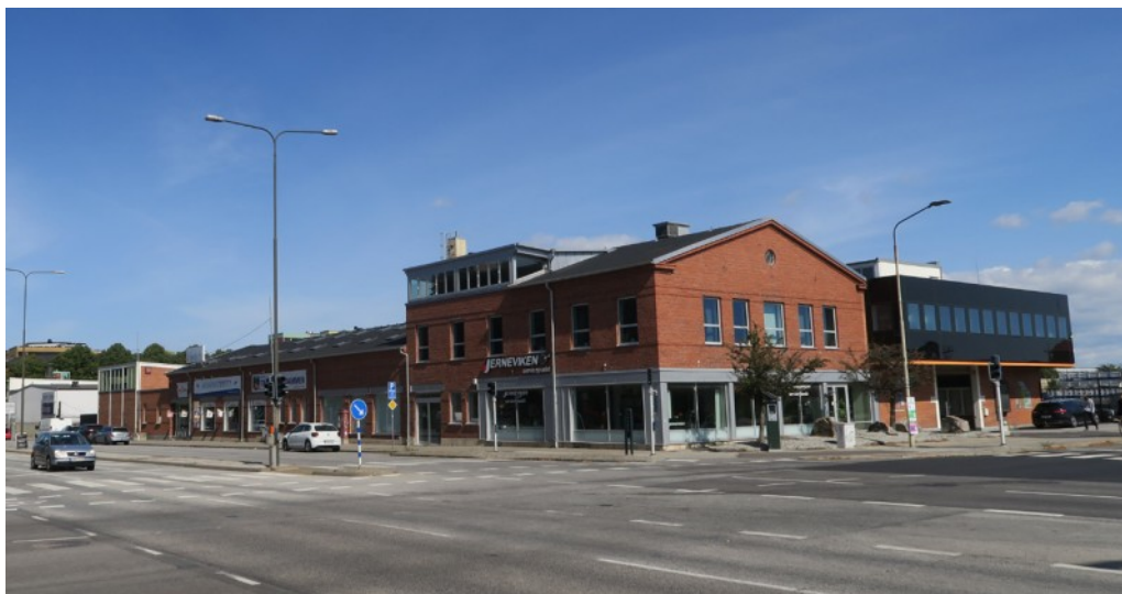
Den äldsta byggnaden inom fastigheten Smedjan 9, ursprungligen Barnekows fabrik. Byggnaden har kvar mönstermurningar och linjeringar i fasad. Fotografi: Tengbom, Tyréns.
