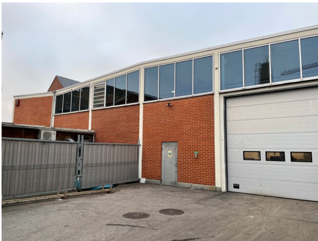
Glaslagerbyggnads södra fasaden. Indelningarna i vit betong markerar tillsammans med fönsterbanden och det veckade taket. Under sent 1900-tal byttes partier i fasad från glas till dörrpartier och igensattes med tegel. Fotografi: Tengbom, Tyréns.
