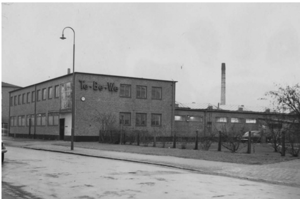
Foto från 1940-talet av den en ursprungliga fabriksbyggnaden från 1939 på fastigheten Smedjan 2. Foto: fotograf okänd.
