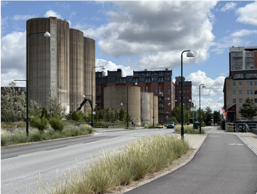
Foto över planområdet från Övägen i sydväst. På bilden syns de tre höga och de tre låga silor som står inom planområdet idag. Foto Malmö stad.
