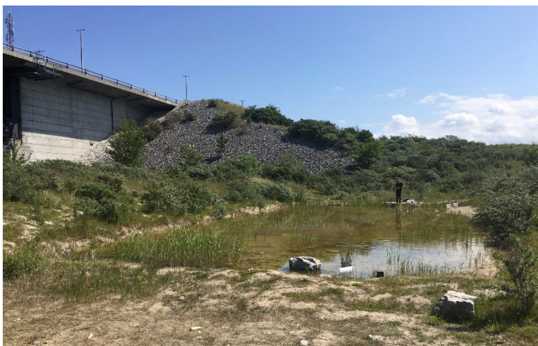
Figur 6. Nygrävd damm år 2006.
