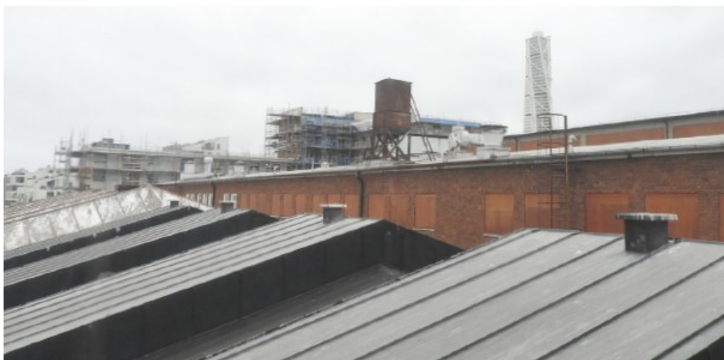
Fasad mot söder på Personalhusets norra länga. I förgrunden syns hallbyggnadens tak med lanterniner. Källa: Olga Schlyter.
