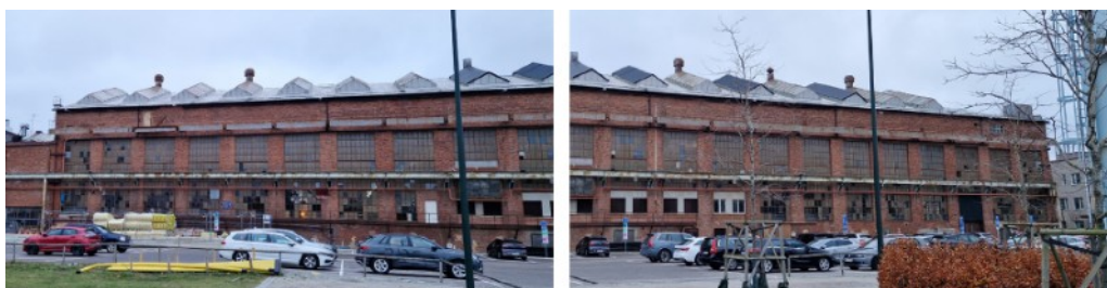
Plåtslageriets västra fasad. Källa: Olga Schlyter.
