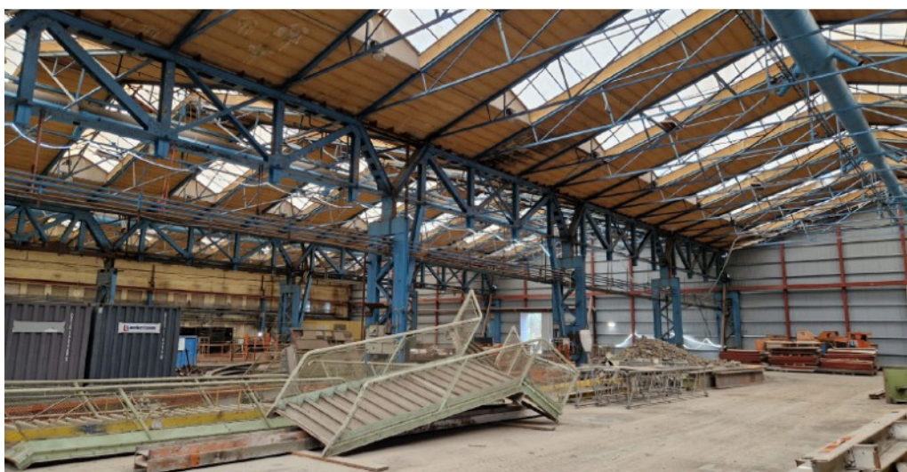
Vy över interiör på plåtslageriet. Källa: Olga Schlyter.
