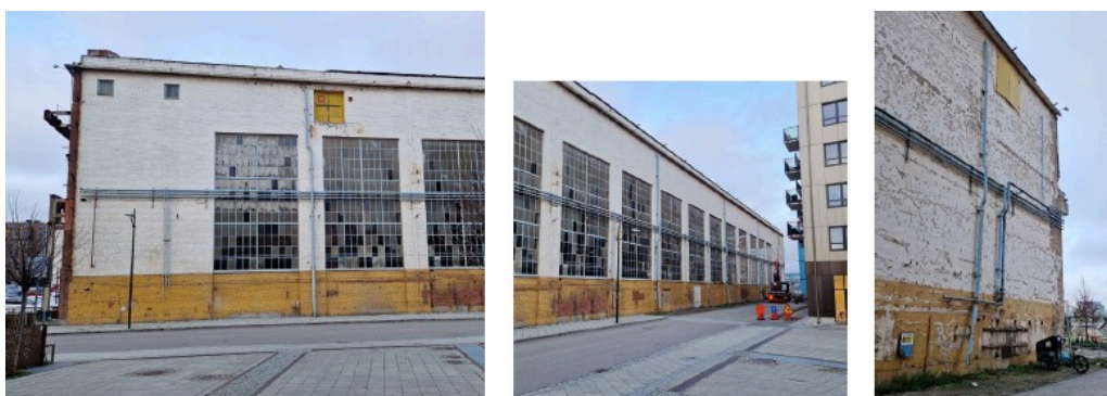
Plåtslageriets södra fasad. Källa: Olga Schlyter.
