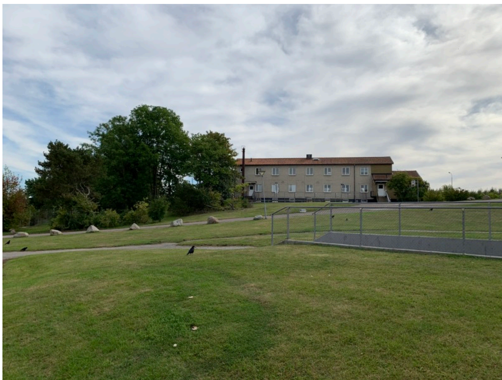
Fotografi, 2022, mot den tidigare stabsbyggnaden i östra planområdet. Vy mot öst.
