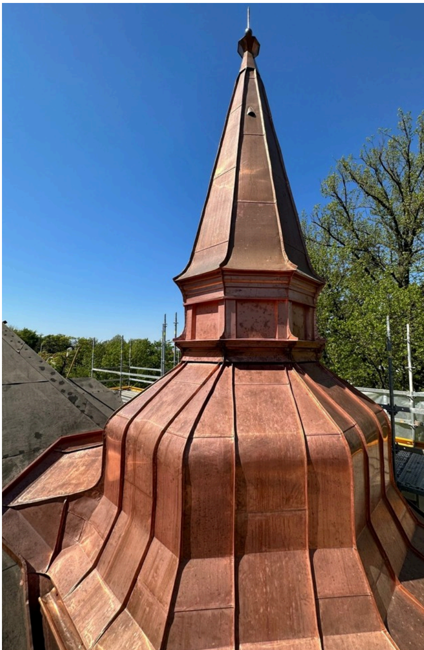
Tornspiran, renoverad med nytt koppartak.
