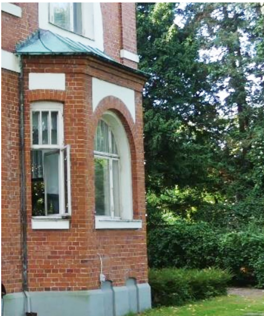
Burspråket med koppartak och stupröret.
