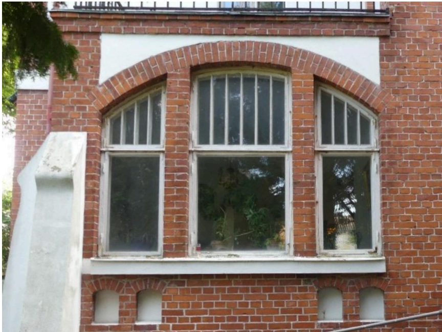
Tidstypiska originalfönster med spröjsade övre lufter och hörnbeslag. Originalfönster kan restaureras med handblåsta glas i ytterbågen.
