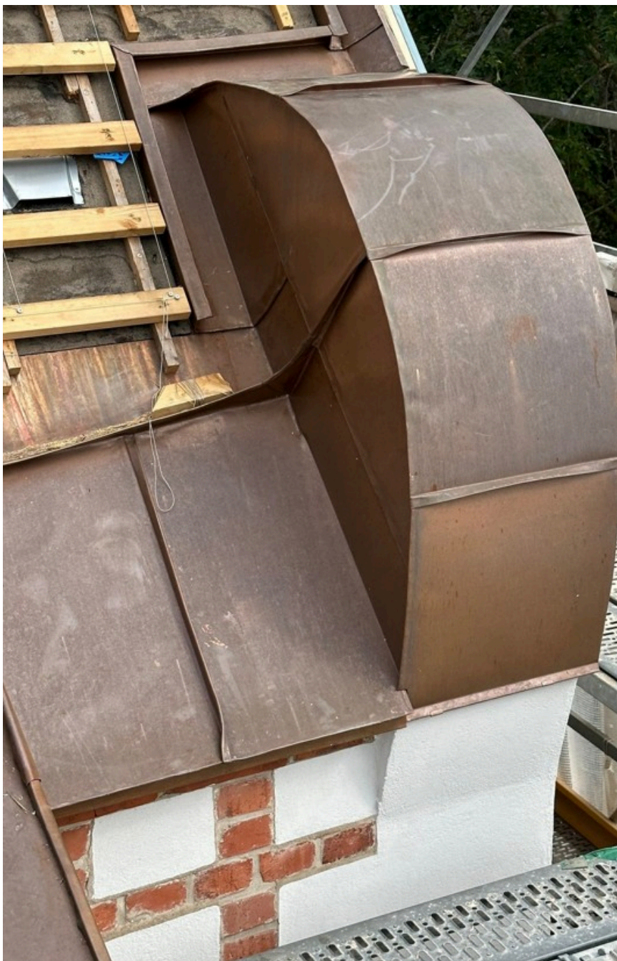
Renovering av detalj på gavelpartiets avslut.
