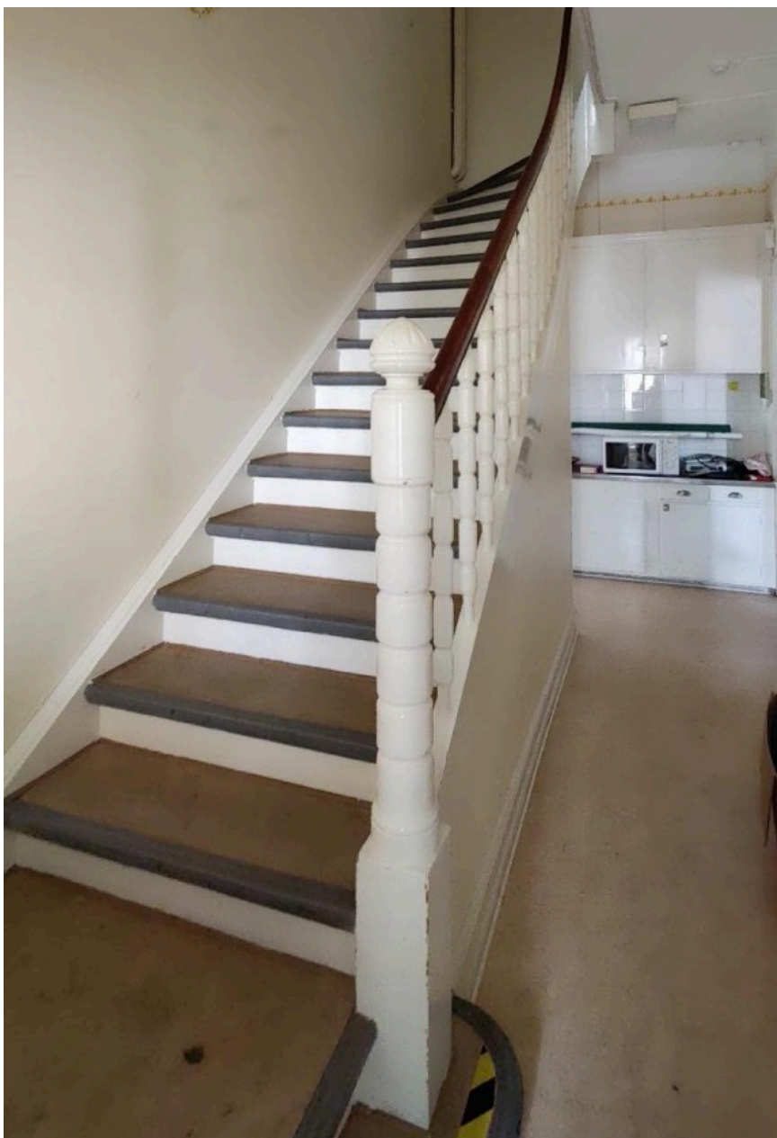
Ursprunglig trätrappa, som kommer att renoveras och kompletteras med nya delar i trä som liknar de ursprungliga.
