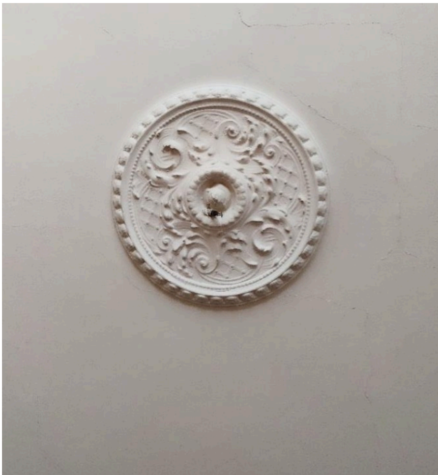
Exempel på renoverad takstuckatur som har monterats ner, gjutits av och kompletterats med nytillverkade.
