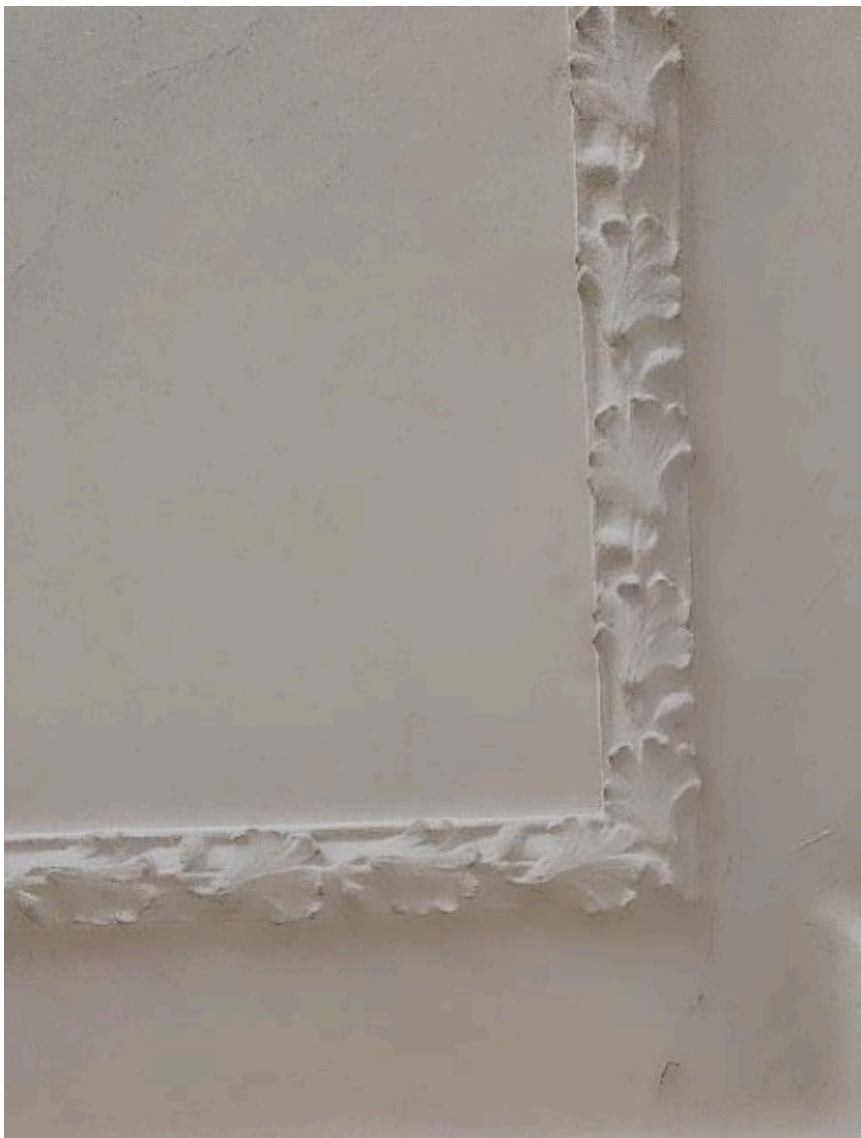
Exempel på renoverad takstuckatur som har monterats ner, gjutits av och kompletterats med nytillverkade.
