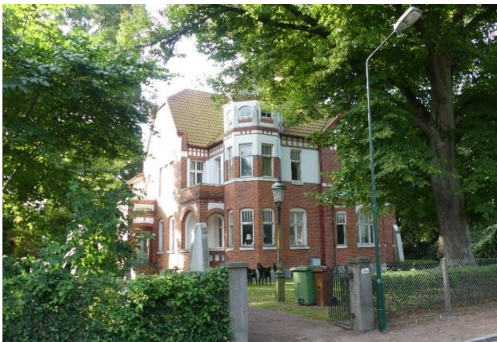
Bild tagen från Rosenholms allé mot fastigheten, med parklinden synlig till höger om byggnaden.
