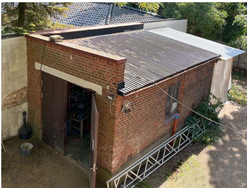
Ekonomibyggnaden och mur i fastighetsgräns mot öster (Malmö stad, 2024).
