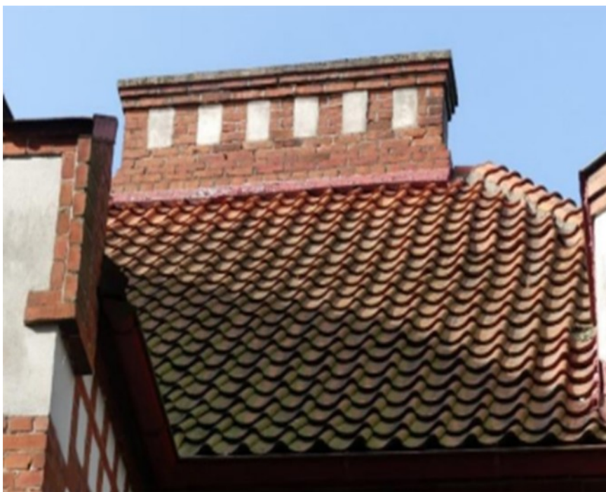
Dekorativt utformade originalskorstenar.
