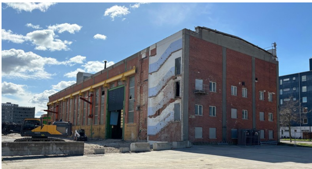
Gavel mot norr och fasad mot öster. Den norra fasaden har inte de stora öppningarna som övriga fasader har. Bilden är tagen efter rivning av den östra hallen.
