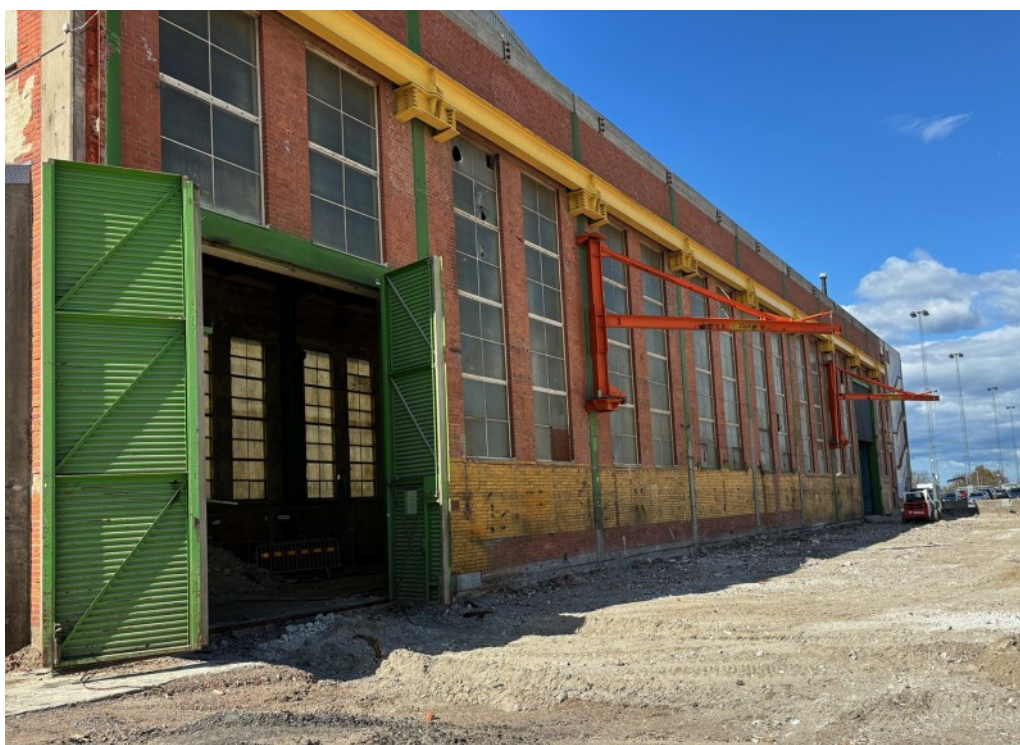
Fasad mot öster. Traverser och andra detaljer i skarpa gröna, gula och brandgula nyanser som också återkommer inne i hallbyggnaden. Bilden är tagen efter rivning av den östra hallen.
