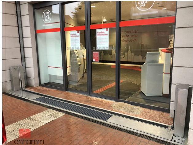
Till vänster: Översvämningsskydd vid entré som placeras ut manuellt. Foto: Legacy Manufacturing. Till höger: Översvämningsskydd vid entré som lyfts upp av vattentrycket. Foto: Anhamm Liquid Barrier Products GmbH.
