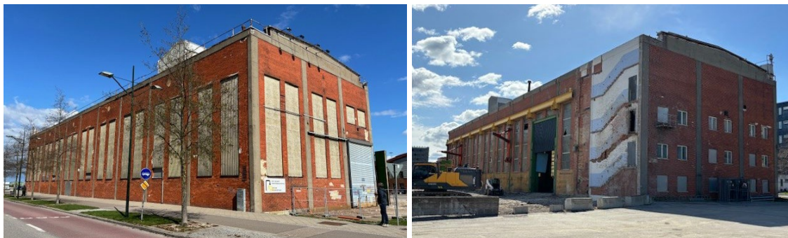
Till vänster: Verkstadshallen direkt väster om planområdet, vy söderifrån, från Östra Varvsgatan. Till höger: Verkstadshallen direkt väster om planområdet, vy från nordväst. Bilder tagna efter rivning av den östra hallen. Foton: Malmö stad.
