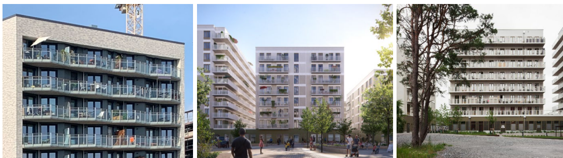
Bebyggelse som genom sin fasadutformning, bland annat balkongernas placering och utförande, riktar sig direkt mot en plats, exempelvis ett torg. Till vänster: Foto: Malmö stad. Mitten och till höger: Bilder från kvarteret Flanören i Uppsala, Jägnefält Milton arkitekter. Mitten: Illustration Zynka. Till höger: Foto Victor Johansson.
