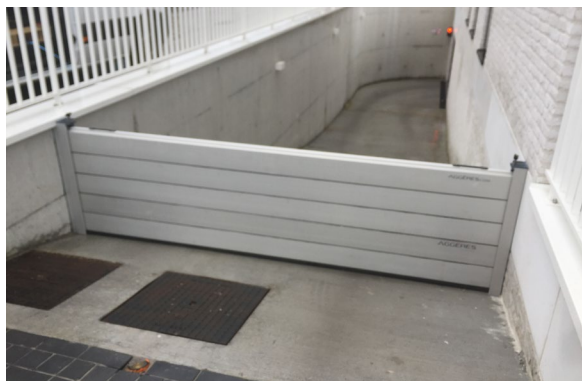
Till vänster: Vattentäta luckor som kan stängas för entré som skydd. Foto: Paul Richard. Till höger: Skydd vid nedfart, exempelvis till garage. Foto: Aggeres.
