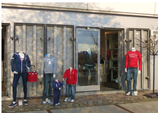
Till vänster: Vattentäta luckor som kan stängas för entré som skydd. Foto: Paul Richard. Till höger: Skydd vid nedfart, exempelvis till garage. Foto: Aggeres.
