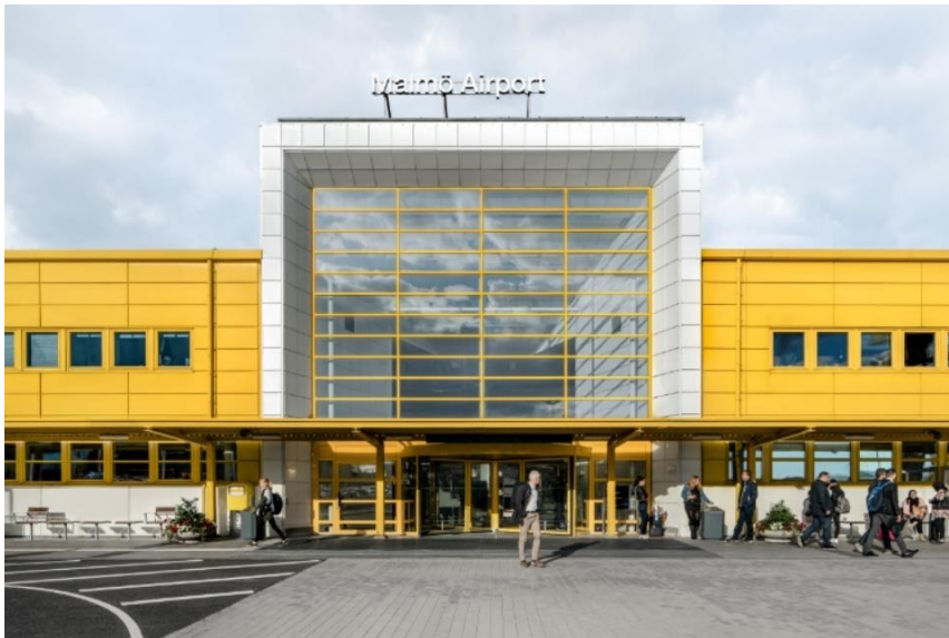
Foto 4. Entrén till terminalbyggnaden.
