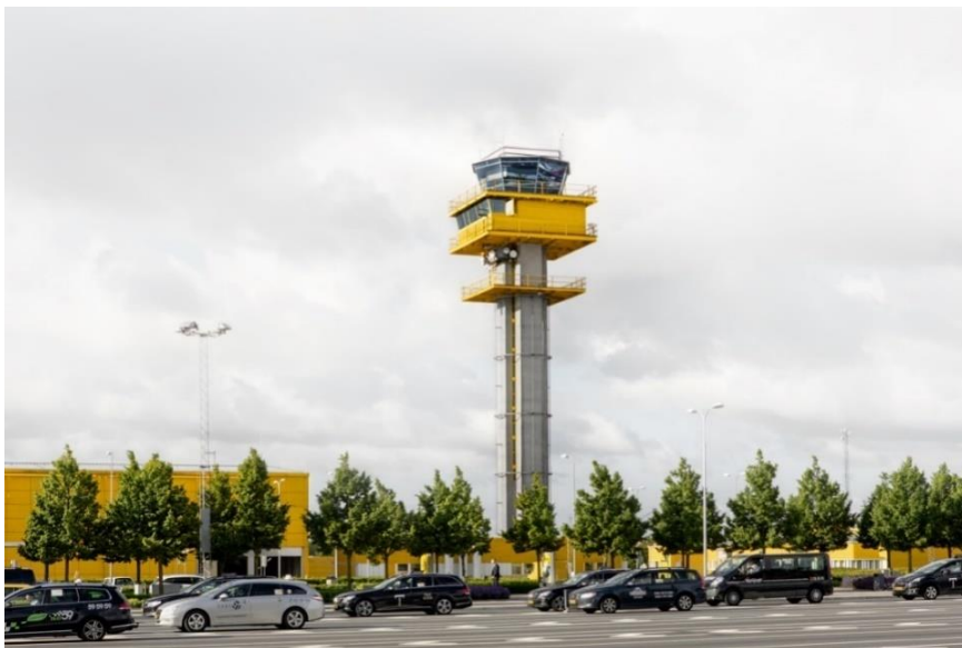
Foto 5. Flygledartornet sett från parkeringsområdet väster om terminalbyggnaden.
