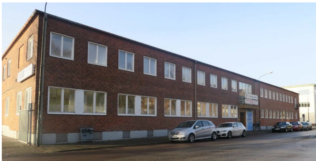
Kontorsbyggnaden på Smedjan 2 utmed Celsiusgatan.
