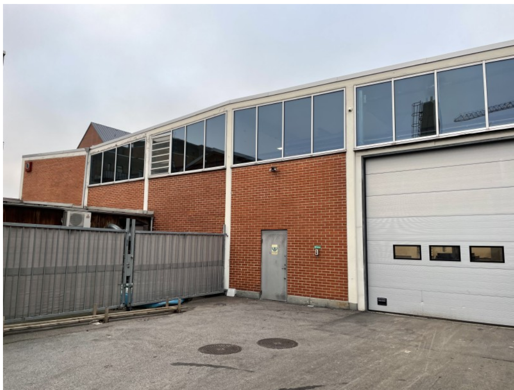
Glaslagerbyggnads södra fasaden. Indelningarna i vit betong markerar tillsammans med fönsterbanden och det veckade taket. Under sent 1900-tal byttes partier i fasad från glas till dörrpartier och igensattes med tegel.
