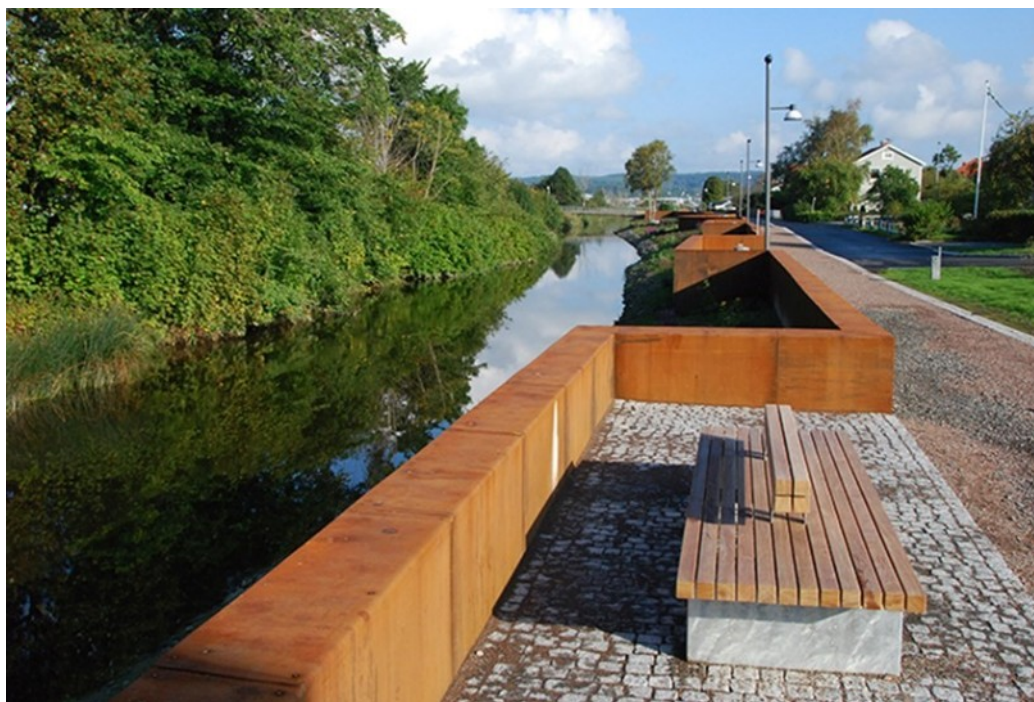
Exempel på fast, multifunktionellt, översvämningsskydd längs Kungsbackaån i Kungsbacka kommun. (Fotograf: Norconsult.)
