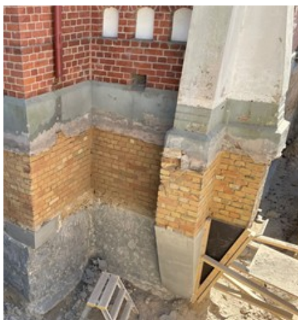
Strävpelare och pågående renovering av fundament till denna.
