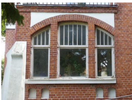
Tidstypiska originalfönster med spröjsade övre luffer och hörnbeslag. Renovering pågår och originalfönster restaureras med handblåsta glas i ytterbågen.
