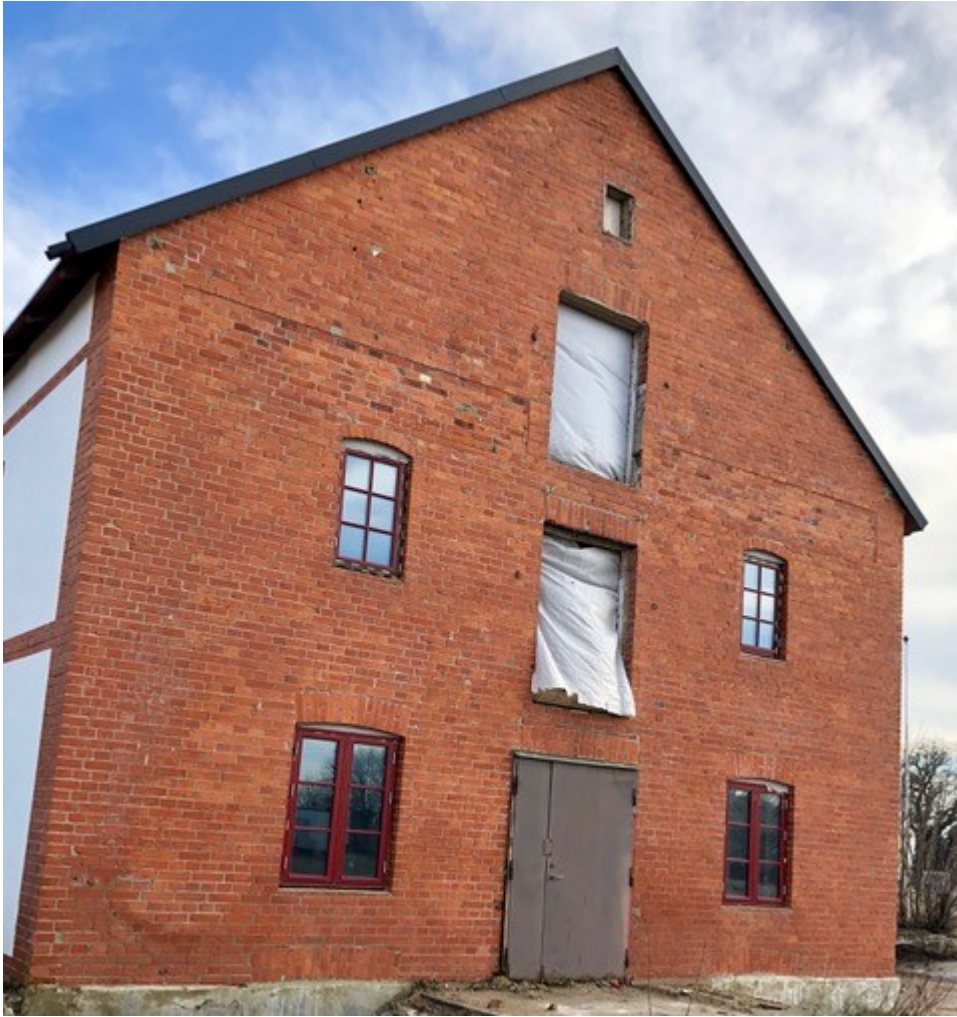
Fotografi över befintlig magasinsbyggnad. Fotot visar byggnadens gavelsida som vetter ut mot Tygelsjövägen.
