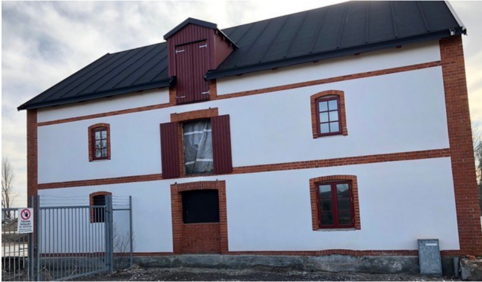
Fotografi över befintlig magasinsbyggnad. Fotot visar byggnadens långsida som vetter mot nordost.
