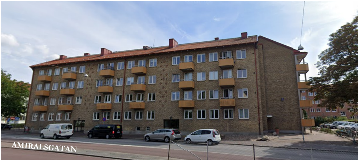
Figur 8. Vy över Ärligheten 2, sedd från Amiralsgatan.
