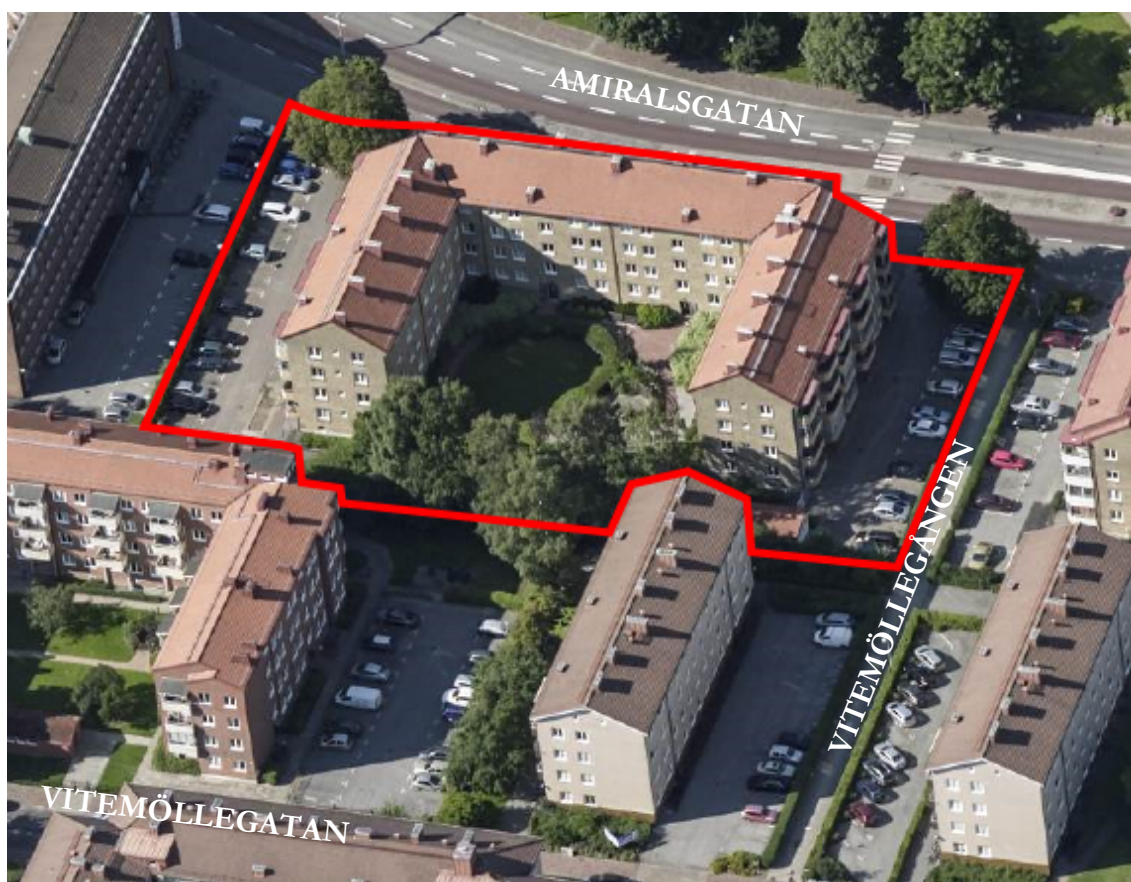
Figur 6. Kvarteret sett från söder. Område där ändring av detaljplanen är markerad med röd linje.
