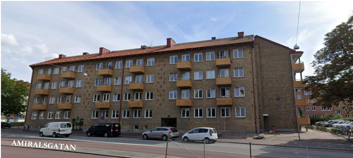
Figur 8. Vy över Ärligheten 2, sedd från Amiralsgatan.
