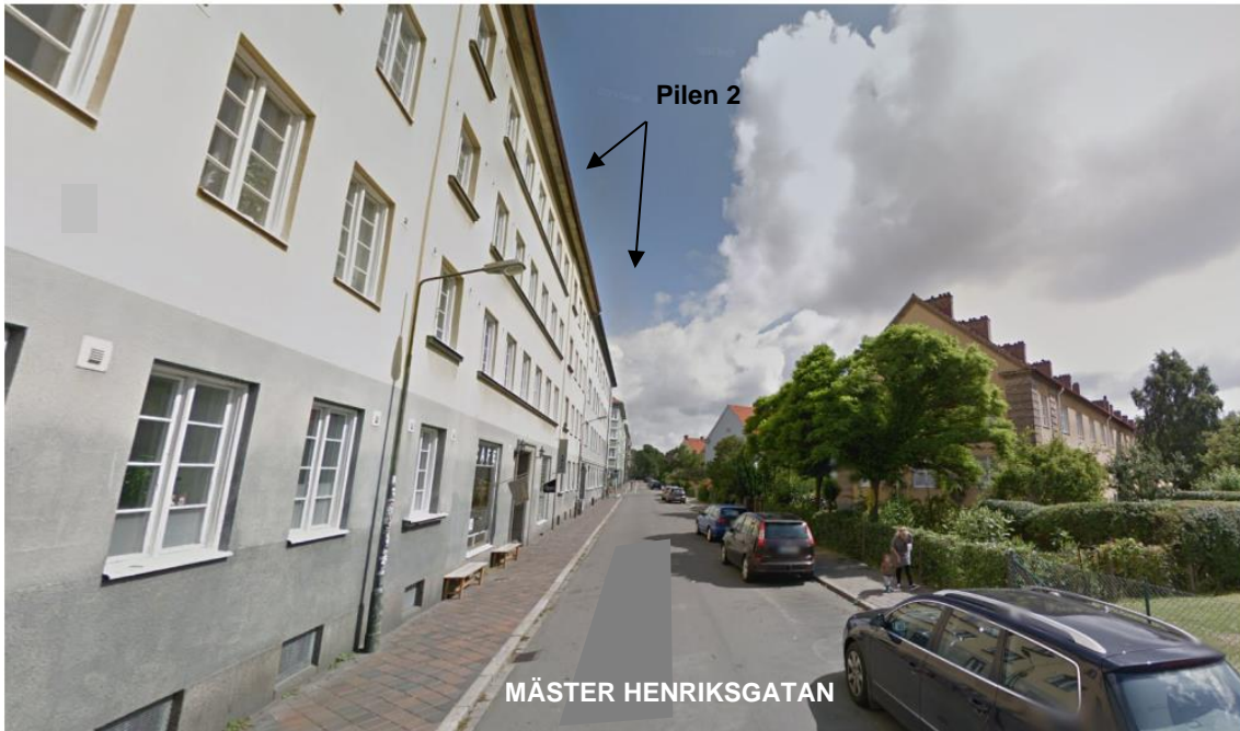
Figur 8. Fastigheten Pilen 2 sedd från Mäster Henriksgatan, från söder.
