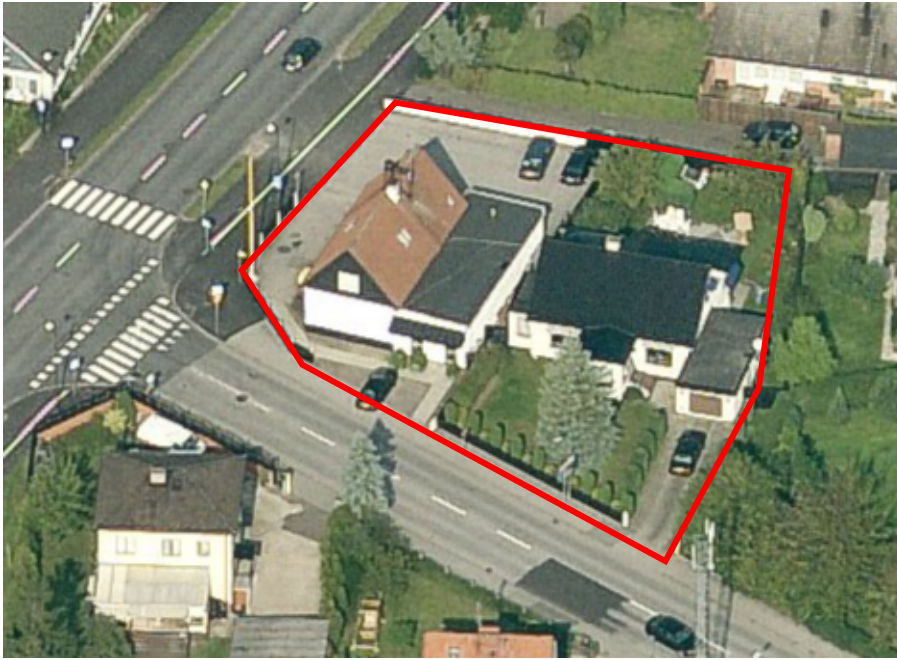
Snedbild över fastigheten sedd mot norr.
