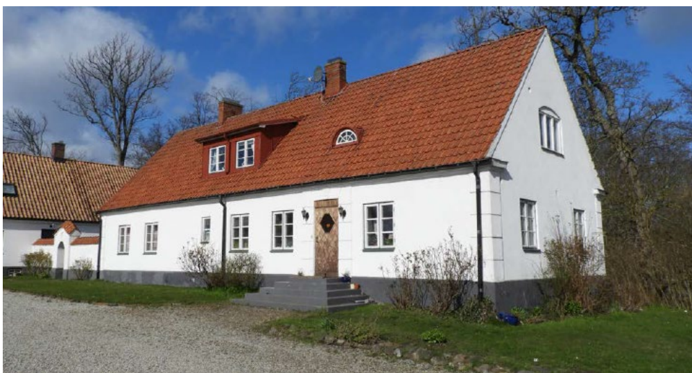
Flygelbyggnaden från söder. Foto: Olga Schlyter
