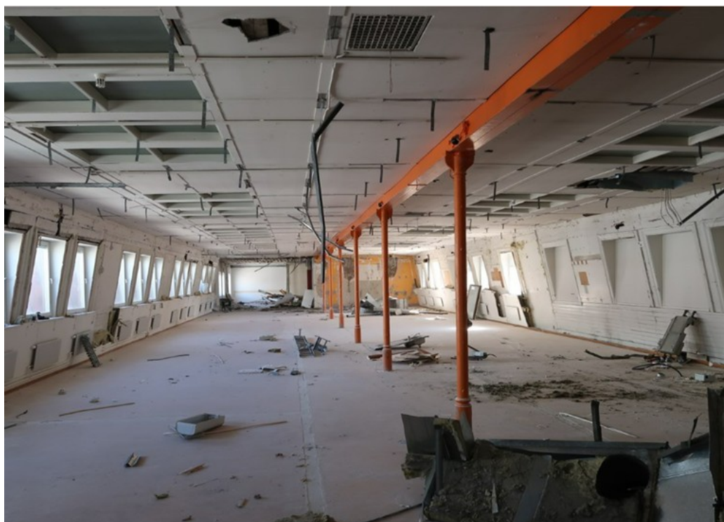
Figur 10. Bilden visar pelarkonstruktionen med gjutjärnskolonner i byggnad mot Västra Rönneholmsvägen, som enligt ny bestämmelse q_3 ska bevaras.
