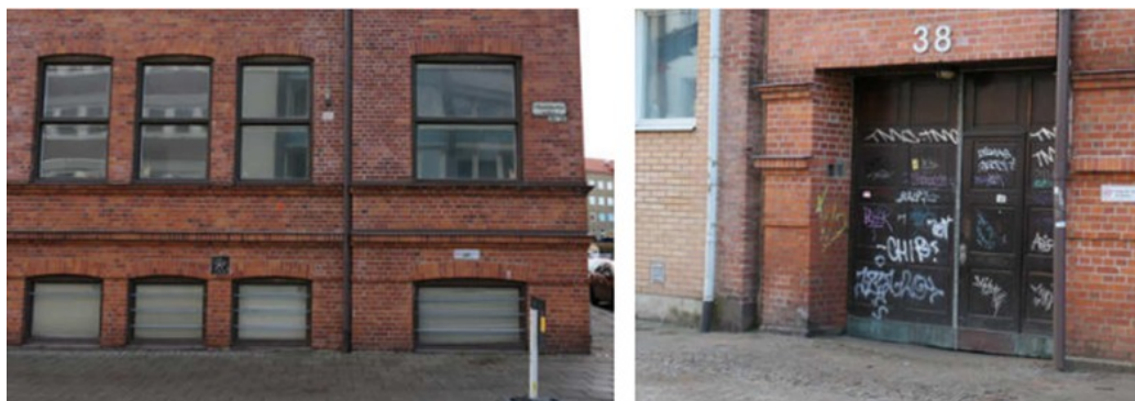
Figur 15. Huvudbyggnad mot Västra Rönneholmsvägen. Fönstren med horisontell indelning sattes in år 1946 och ersatte tidigare spröjsat utförande. Porten är ursprunglig.
