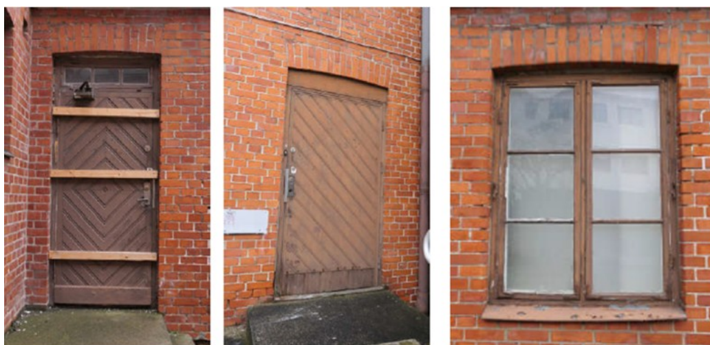
Figur 16. Ursprungliga portar och originalfönster på den före detta portvaktsbostaden.
