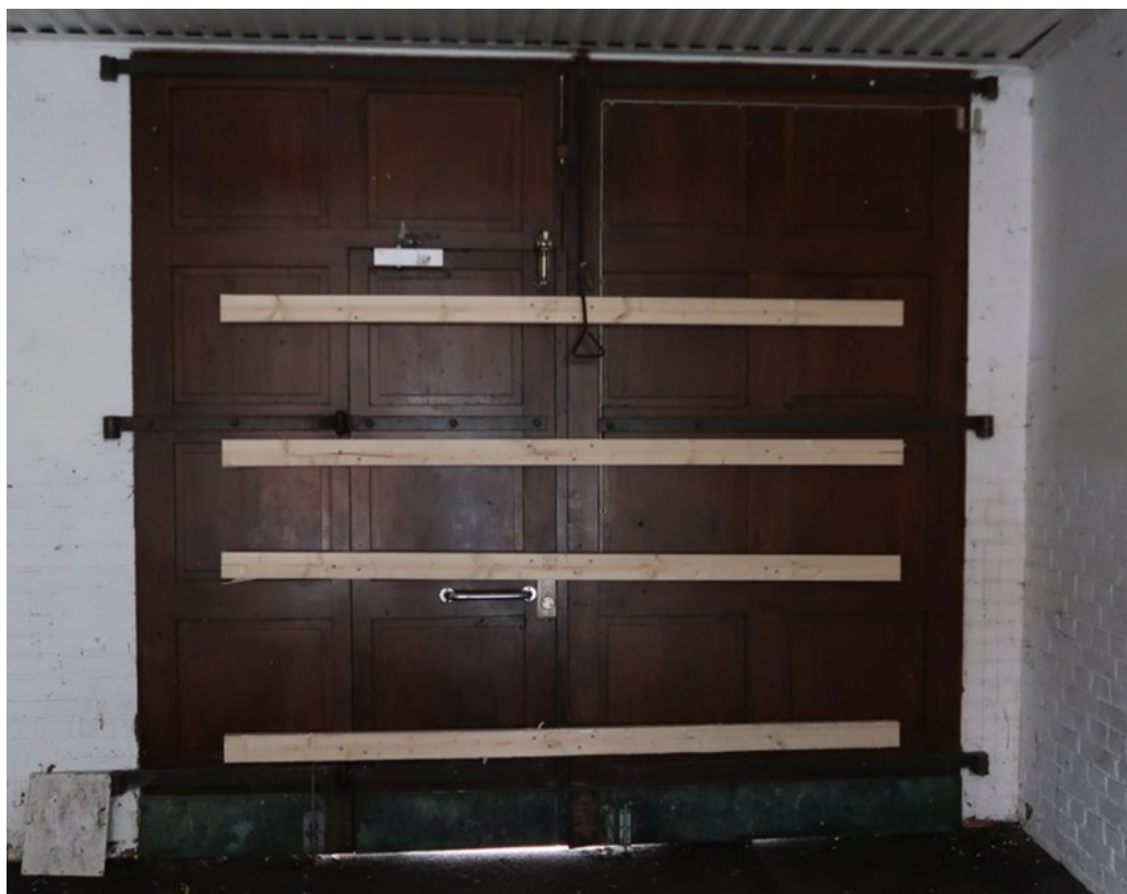
Figur 9. Bilden visar ursprunglig port i fernissad ek på huvudbyggnad mot Västra Rönneholmsvägen, som enligt ny bestämmelse q_2 , ska bevaras.
