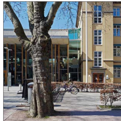
Exempel där ny byggnad möter gammal, från norra sjukhusområdet.
