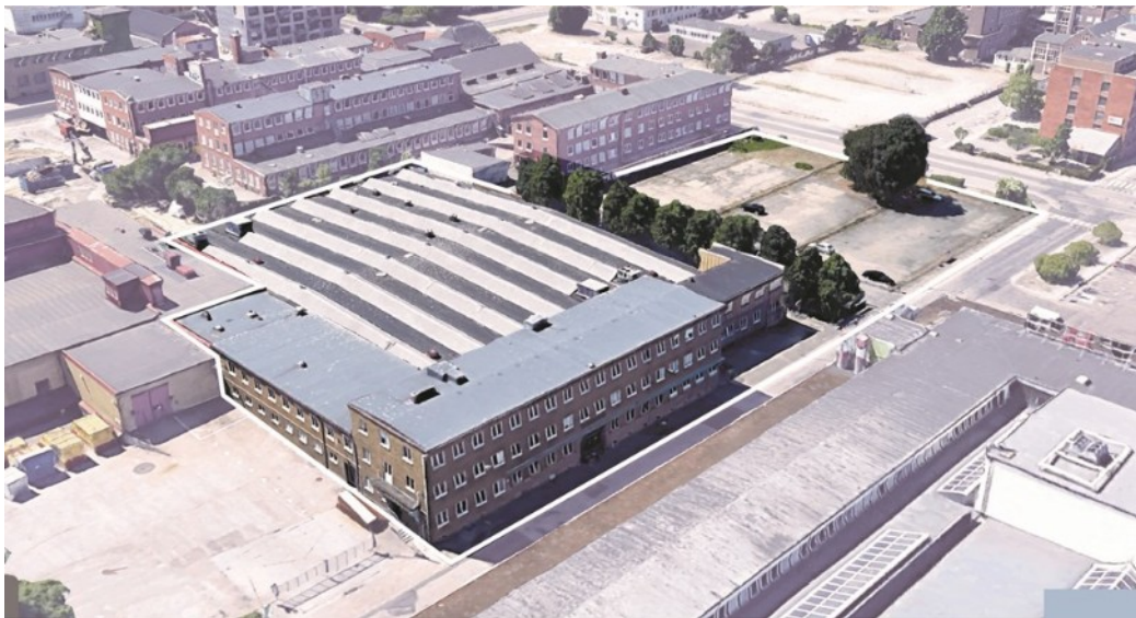
Flygfoto från nordost av fastigheterna Spiralen 11 till vänster och Spiralen 6 till höger.
