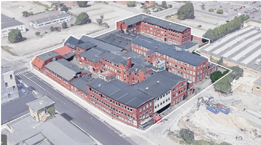
Flygfoto av fastigheten Spiralen 10 . Hela fastigheten bedöms enligt PP6020 ha den högsta bevarandegraden.
