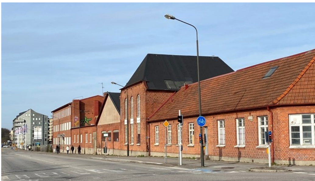
Fasader i rött tegel på fastigheten Spiralen 10 utmed Östra Farmvägen.
