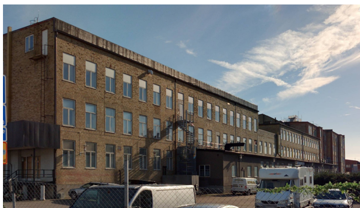
Byggnad 7, vänsalsbyggnadens fasad mot väster.
