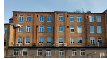
Fabriksbyggnadens fasad mot väster.
