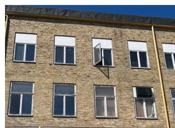
Byggnad 7, vänsalsbyggnadens fasad mot öster.
