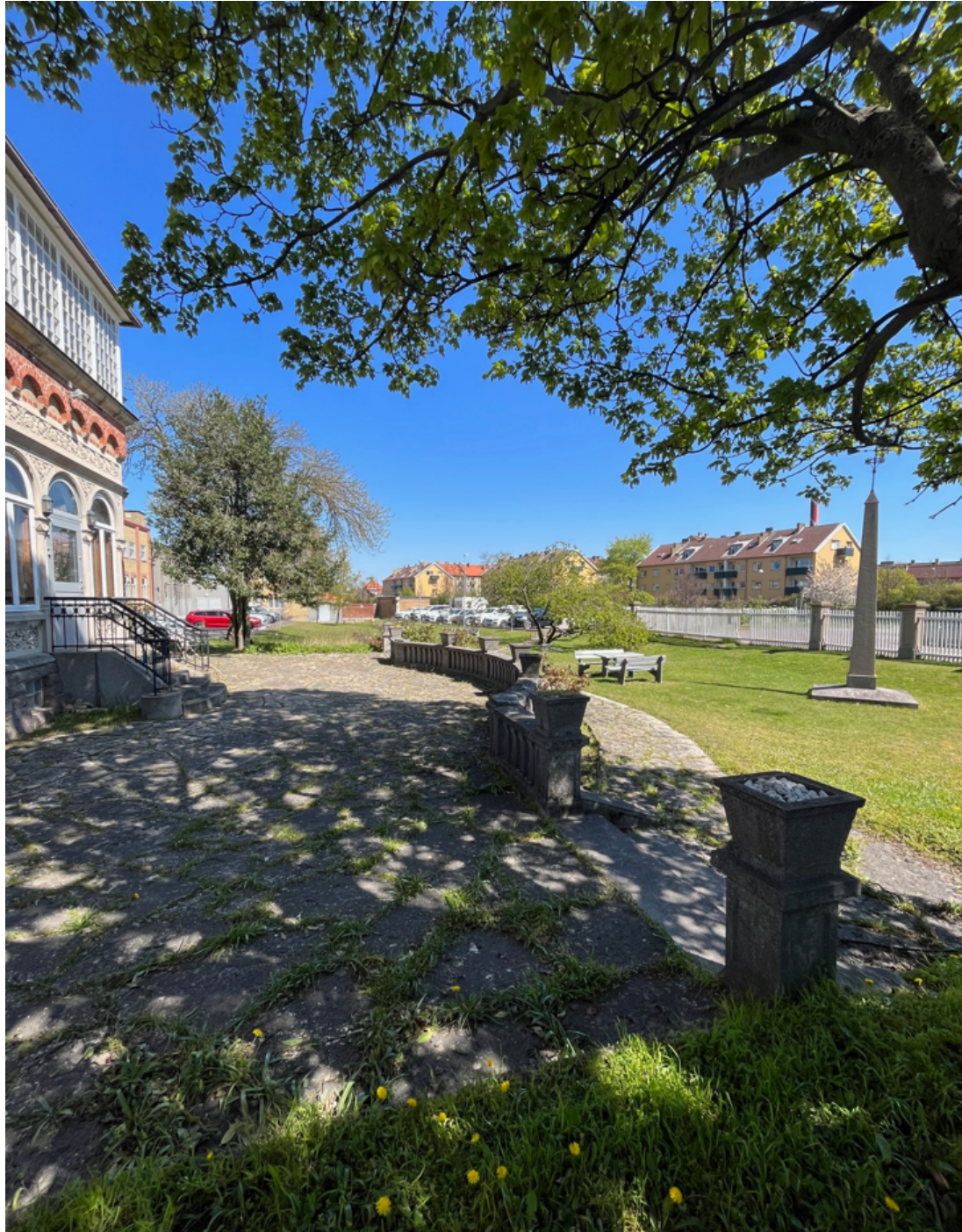
Trädgårdsanläggningen med balustrad, trappor, stenläggning, staket samt järnek och hängask.
