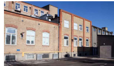
Utbyggnader som byggts på öster om Spinneriet och fabriksbyggnaden.
