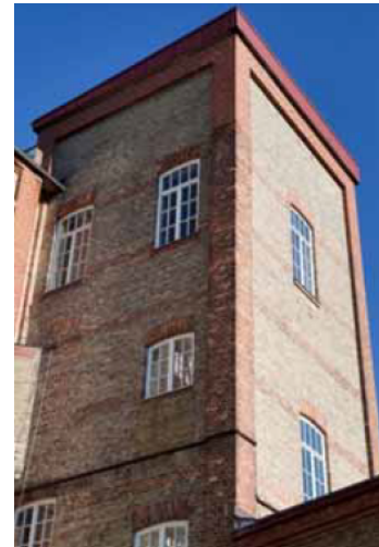
Byggnadsdel med bevarade originalfönster med spröjs.
