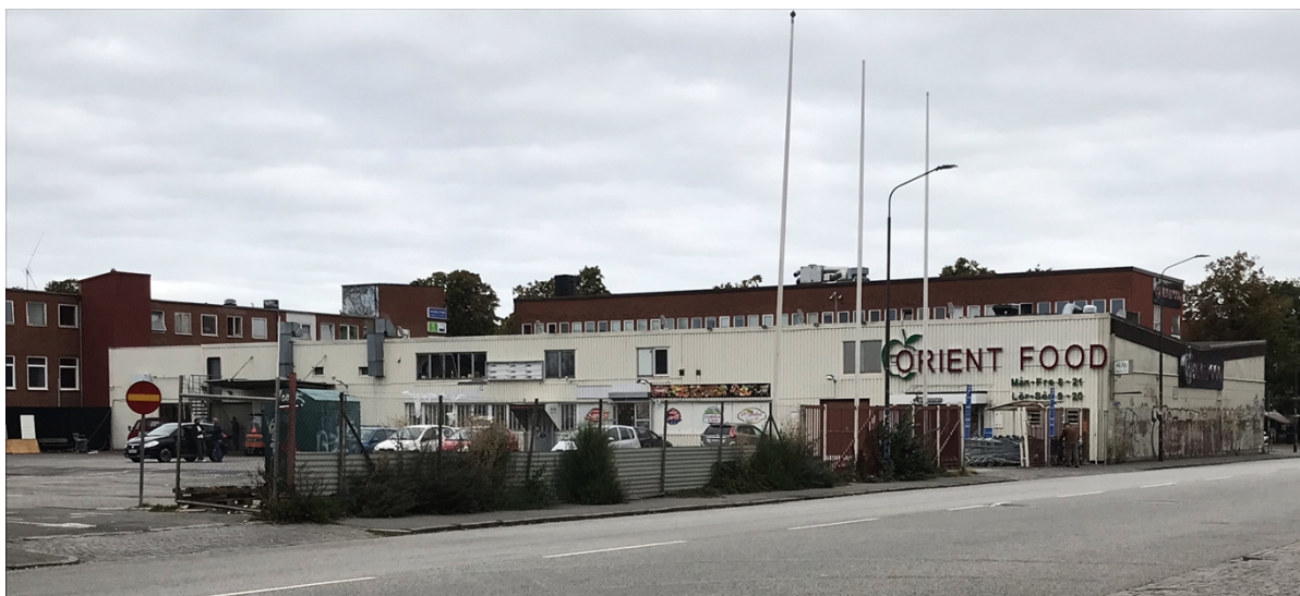
Nuvarande verksamhet inom fastigheten Kampen 23. Befintlig bebyggelse utgörs av en lägre byggnadskropp inom planområdets södra del, synlig i förgrunden, samt en högre byggnadskropp i planområdets norra del, synlig i bakgrunden.
