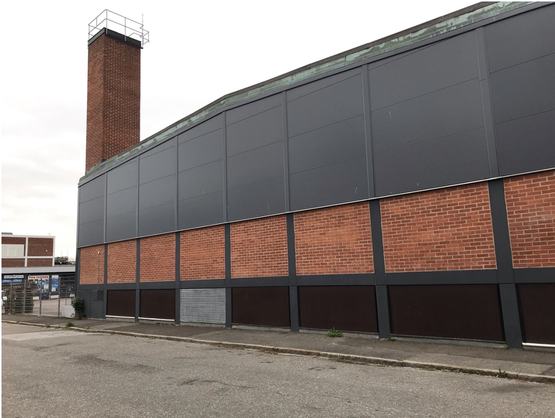
Byggnaden i planområdets södra del med gavel mot Norra Grängesbergsgatan. Byggnaden är försedd med en skorsten och fasadmaterialet utgörs främst av tegel och plåt. De karaktäristiska betongbanden visar på den typiska bebyggelsekaraktären som finns i industriområdet.
