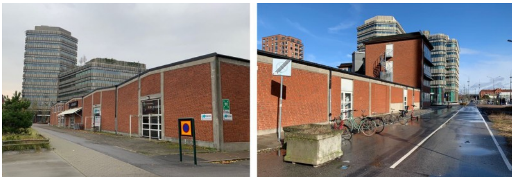
Tv. Vy befintlig byggnad mot kajen. Th. Vy befintlig byggnad mot Neptunigatan. Niagara i bakgrunden.
