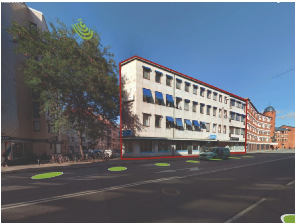
Gatuvy från Föreningsgatan, bebyggelsen på fastigheten markerad med rött.
