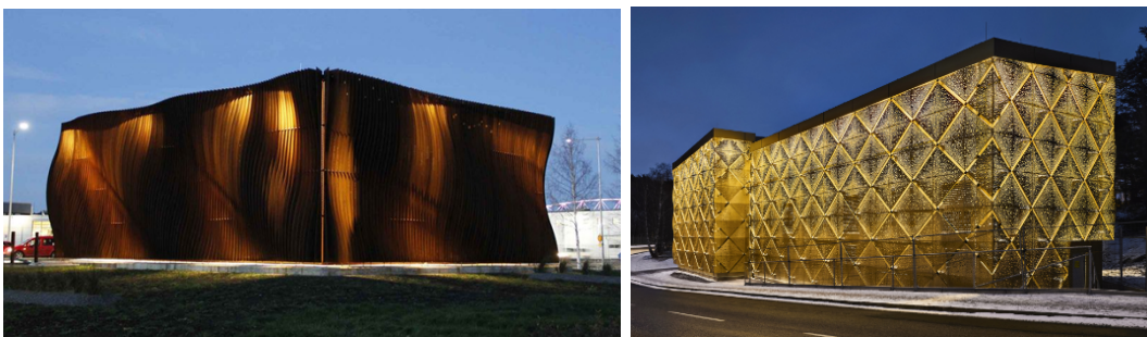
Två exempel på tekniska anläggningar som tillför en upplevelse till stadsmiljön utöver sin funktion. Till vänster: Pumpstation i Luleå (Foto: Therese Engström, Designat Ljus Europa AB). Till höger: Fördelningsstation i Enschede (Foto: Måns Berg).
