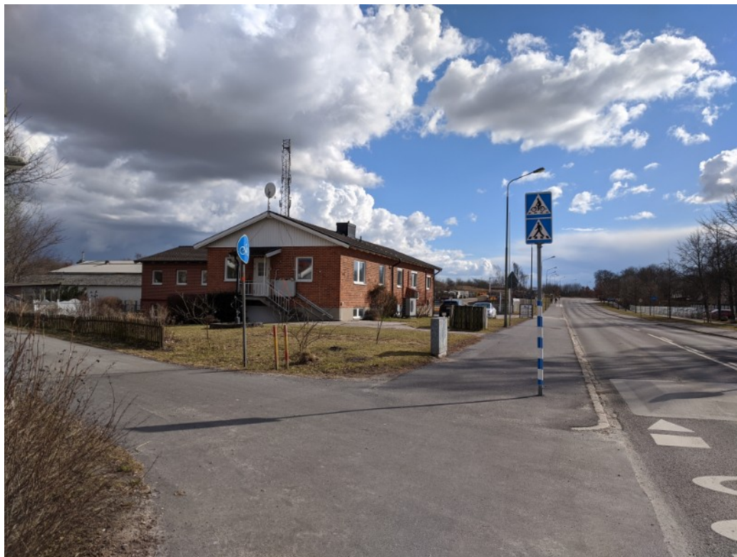
Befintlig byggnad i planområdets norra del som föreslås att rivas. Stadsbyggnadskontoret.
